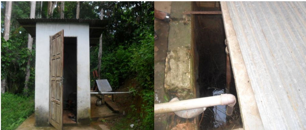
Figura 10: Poço Tubular Profundo, Fordlândia- PA.
