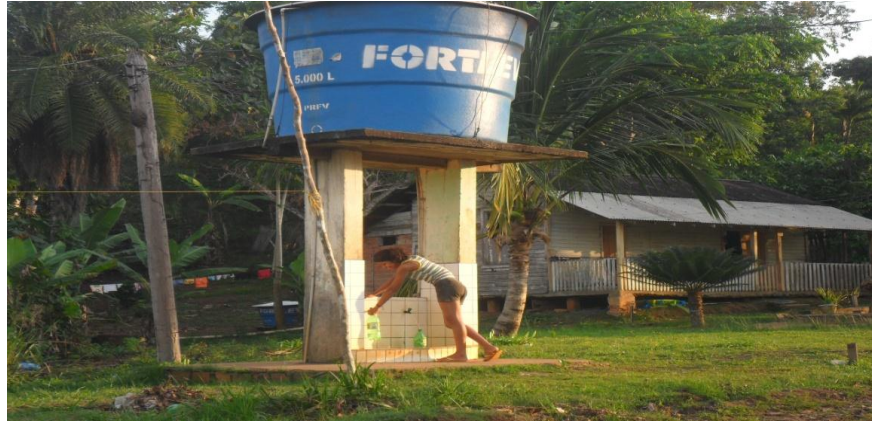
Figura.11:Reservatório de distribuição de água em Fordlândia-PA.
