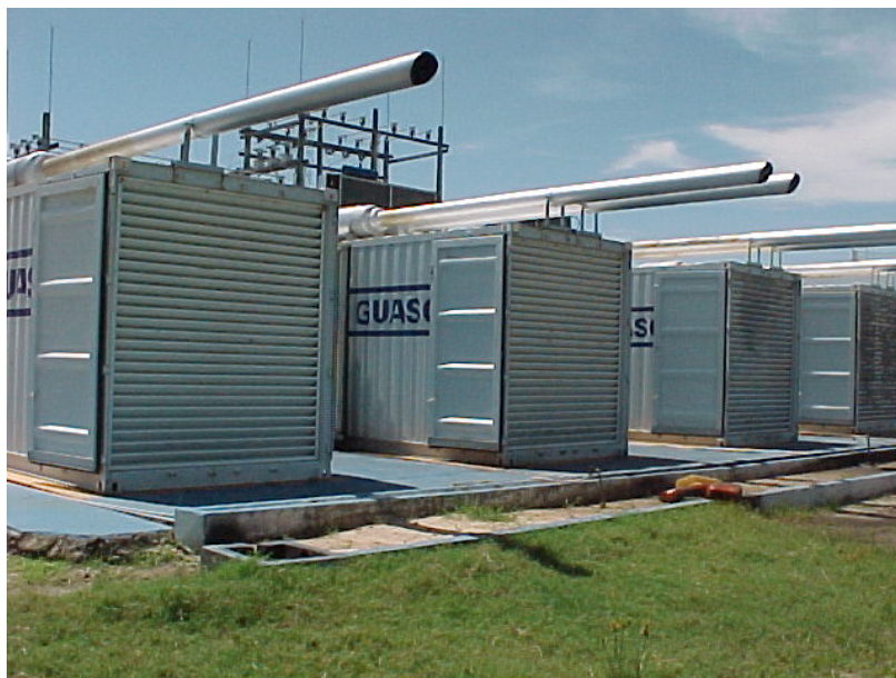
Figura 2.8 - Pátio de Geradores de uma PCT (UTE Salvaterra – Pará).
