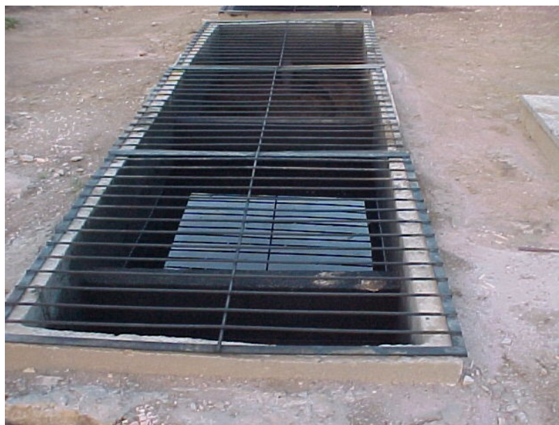
Figura 2.7 - Caixa Separadora Água-Óleo de uma PCT (UTE Novo Progresso – Pará).
