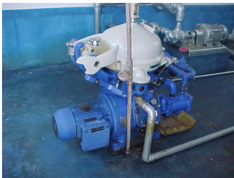
Figura 2.6 - Centrifugação e Filtragem em uma PCT (UTE Salvaterra – Pará).
