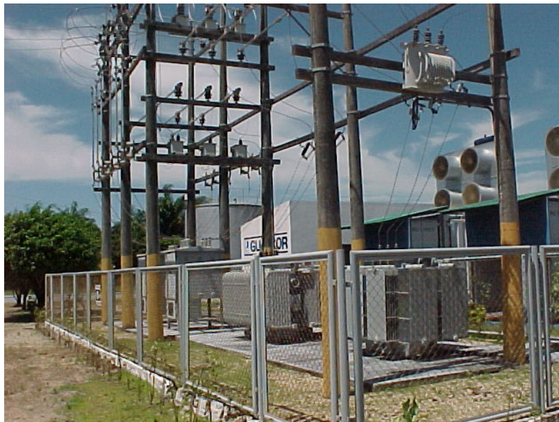
Figura 2.9 - Subestação de uma PCT (UTE – Salvaterra / Pará).
