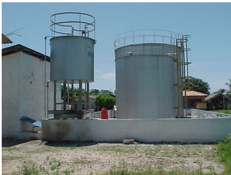
Figura 2.5 - Armazenamento de Combustível de uma PCT (UTE Salvaterra – Pará).
