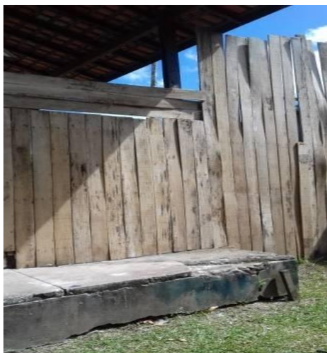
Imagem 17 Cerca de madeira: isolamento da parte inicial do bloco de sala de aula
