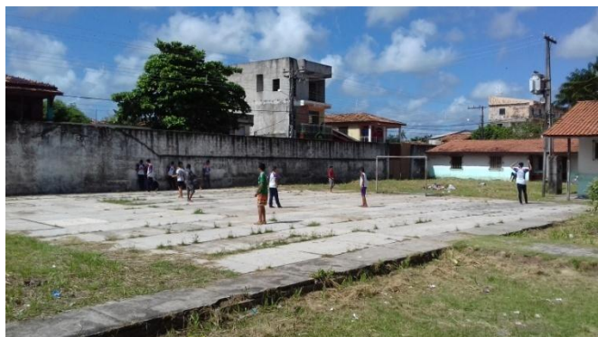
Imagem 7 Área de concreto
