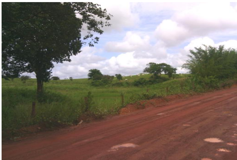
Figura 24 - Estrada vicinal na área da bacia do rio Apeú
