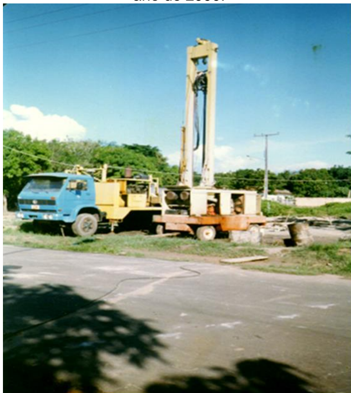
Figura 06: Poço Artesiano profundo no Bairro da Floresta perfurado no ano de 2000.
