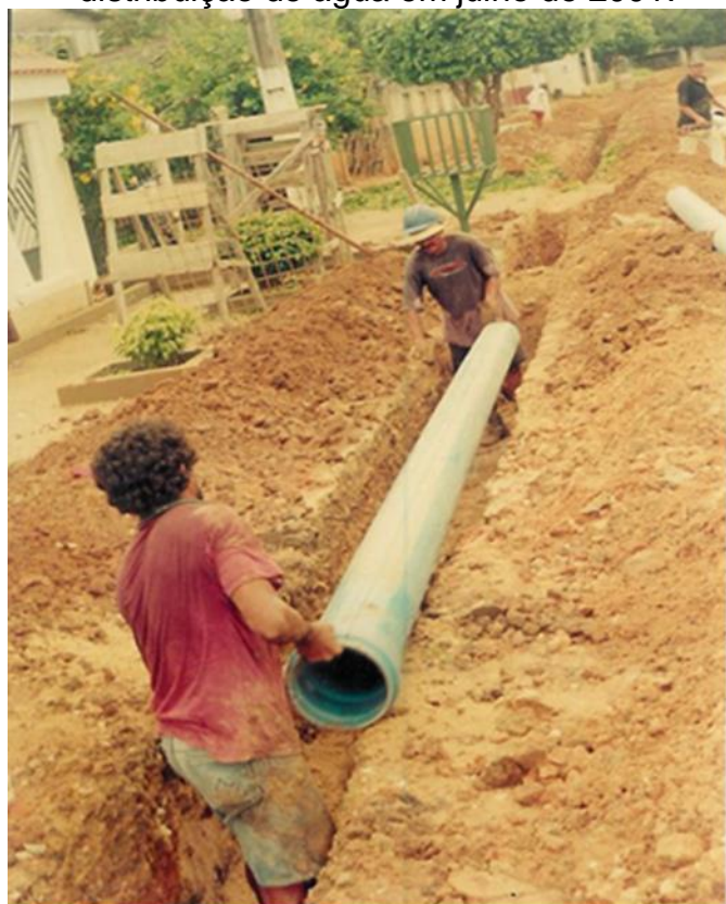
Figura 07: Assentamento de tubos para conclusão da rede de distribuição de água em julho de 2001.
