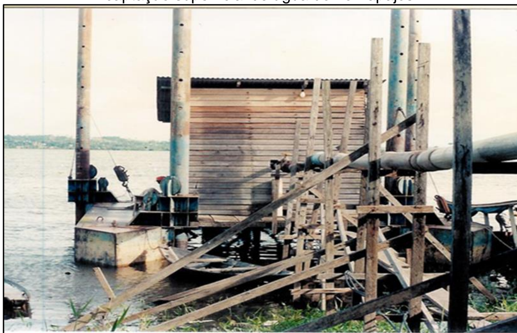
Figura 05: Antiga Casa de Bomba construída em 1980 para realizar a captação superficial de água do rio Tapajós.
