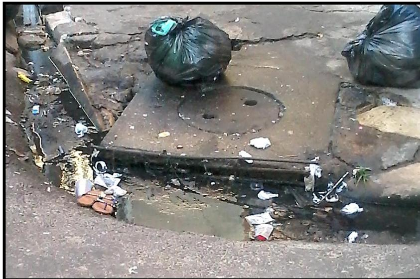
**Figura 14:** Boca de Lobo da rua 15 de Novembro, parcialmente obstruída e danificada.
