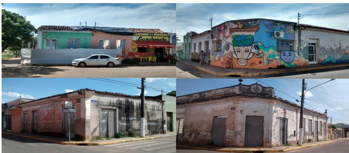
Figura 8: Parte do Conjunto Arquitetônico e Paisagístico de Cáceres-MT, tombado, em péssimo estado.
