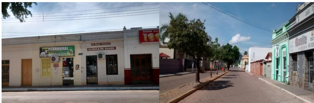
Figura 7: Parte do Conjunto tombado após reformas e construções
