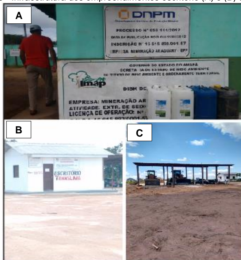
Fotografia 3 - Infraestrutura dos empreendimentos escritório (A) e (B) e Galpão (C).
