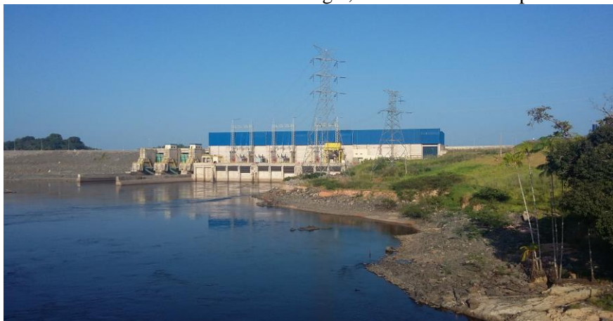
Fotografia 14 - Hidrelétrica Ferreira Gomes Energia, instalada no município de Ferreira Gomes
