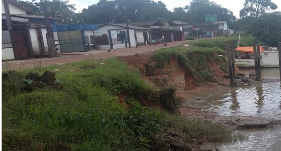
Fotografia 5 - Infraestrutura de uma Rua do Município de Calçoene
