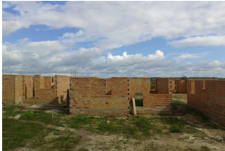
FIGURA 15 - ÁREA DO EMPREENDIMENTO MCMV EM AURORA DO PARÁ
