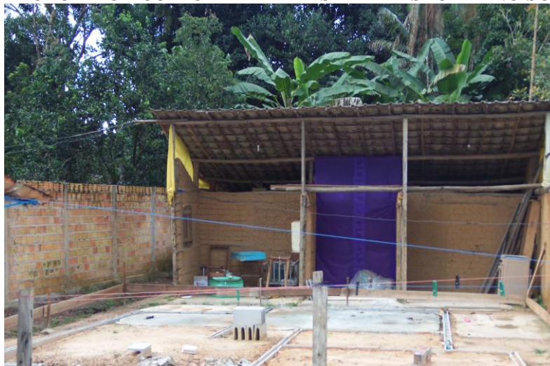
FIGURA 20 - FOTO DE UH COM OBRA PARALISADA EM SÃO FRANCISCO DO PARÁ
