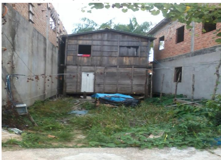
FIGURA 17 - FOTO - TERRENO VAZIO APÓS A DERRUBADA DA UH EM LIMOEIRO DO AJURU
