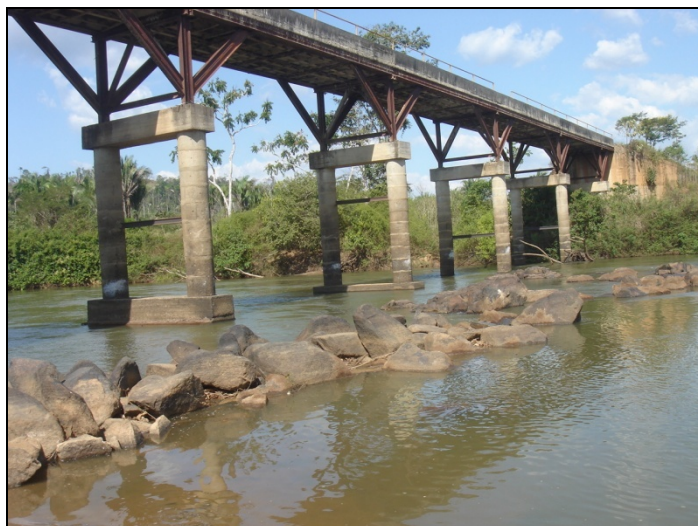
Figura 8 - Ponte de acesso localizada no Assentamento Palmares II Fonte: Michelotti (2009a)
