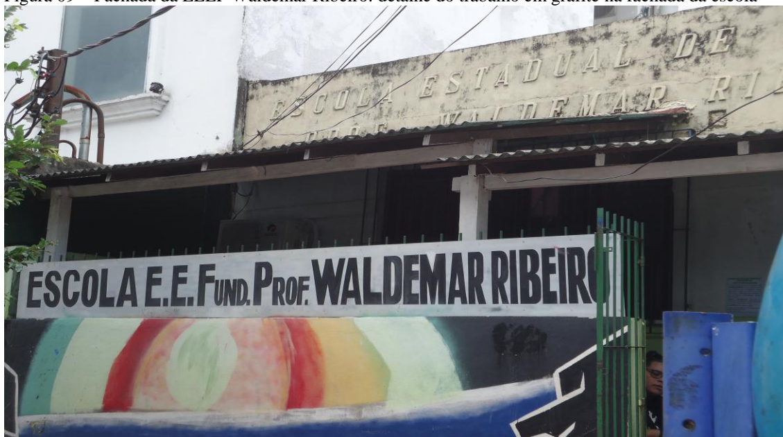
Figura 09 – Fachada da EEEF Waldemar Ribeiro: detalhe do trabalho em grafite na fachada da escola
