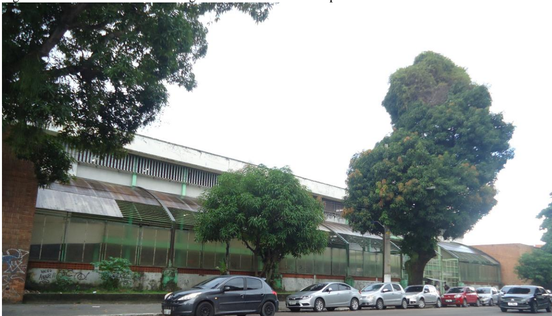
Figura 25 – Fachada da EEEFM Augusto Meira: modernizada por uma estrutura de ferro e vidros
