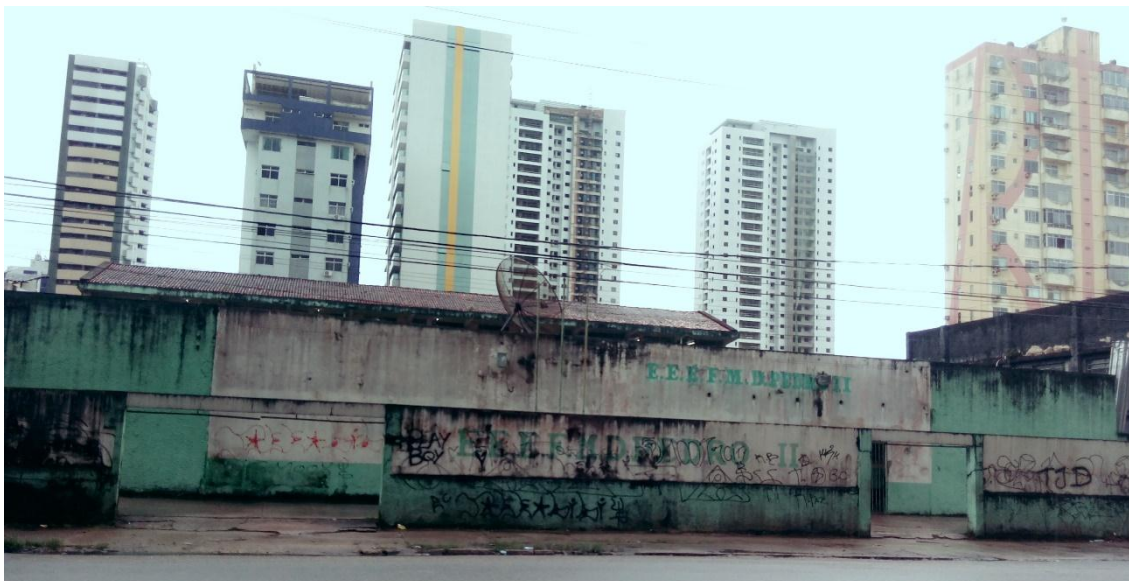
Figura 22 – Fachada da EEEFM Dom Pedro II. O muro alto pichado mal permite avistar o prédio térreo da escola.
