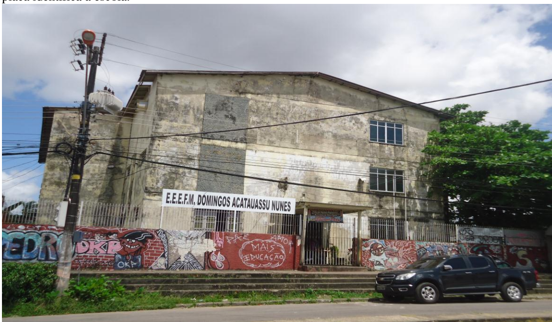
Figura 26 – Fachada da EEEFM Domingos Acatauassu Nunes. Acima das grades do muro grafitado, uma placa identifica a escola.
