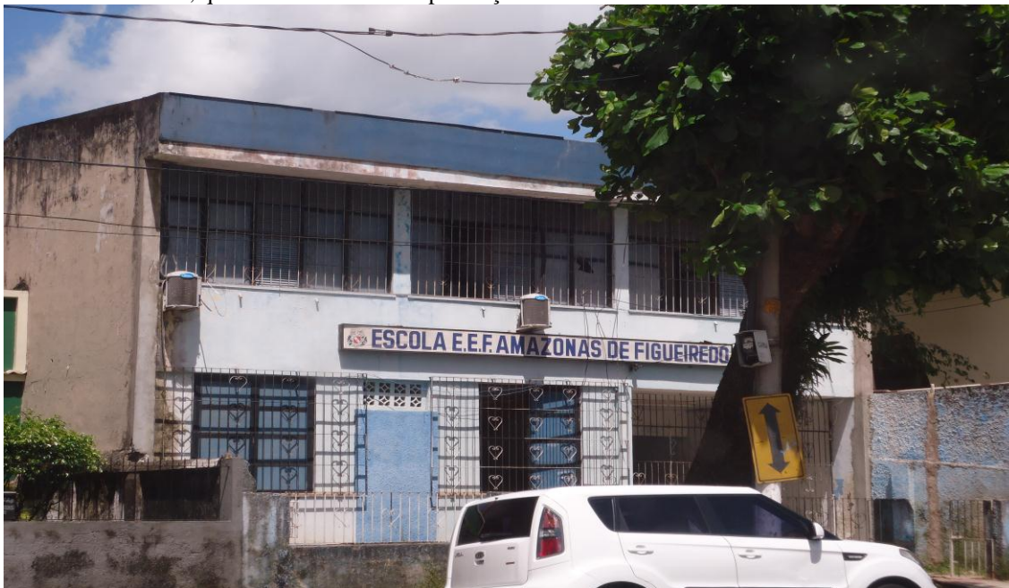
Figura 11 – Fachada da EEEF Amazonas de Figueiredo. Escola de janelas gradeadas, localizada em bairro nobre cidade, quase não se nota a sua presença.
