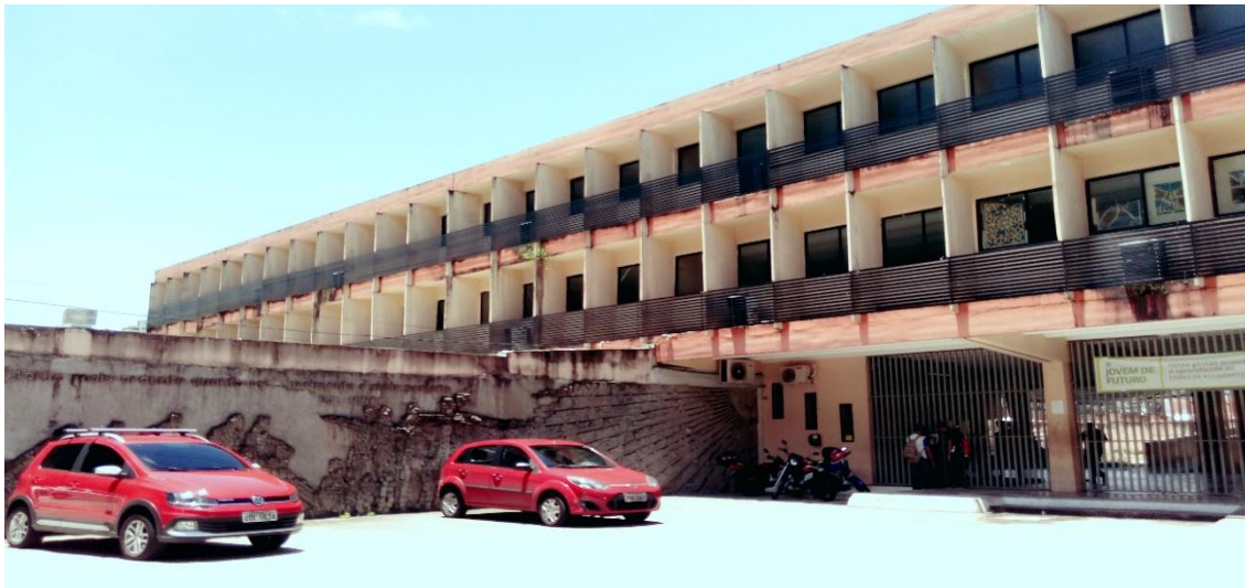
Figura 13 – Fachada da EEEFM Deodoro de Mendonça, um prédio de porte para atender a cerca de 2000 alunos.
