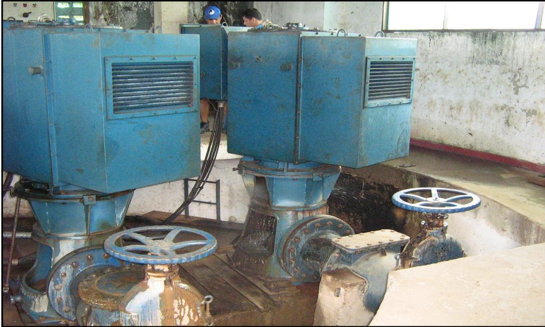
Fotografia 8 – Conjunto de motor-bomba de sucção.
