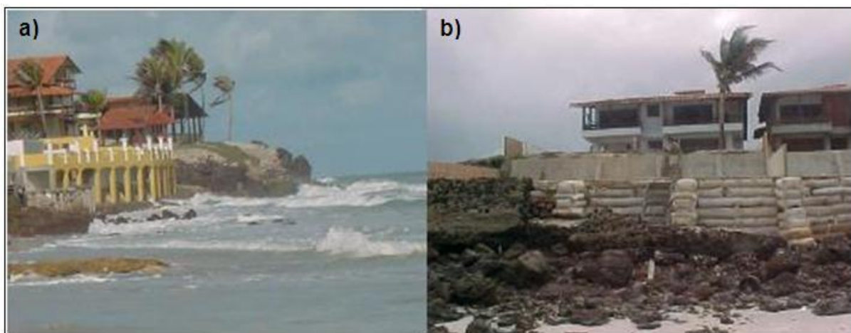
Figuras 19. a) Inundação por maré, erosão das falésias e das obras de infra-estrutura; b) Construção de muros de arrimo para conter a ação das ondas na praia do Atalaia, em Salinópolis. Fonte: MELO (2008).
