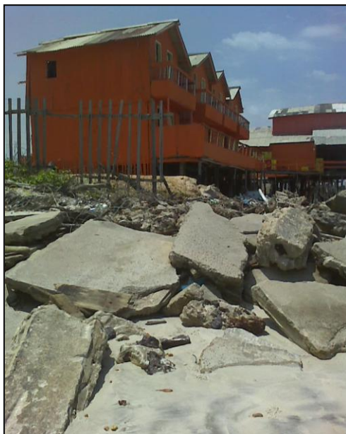
Figura 17. Hotéis localizados na praia de Ajuruteua sob influência da ação das ondas e sujeitos à erosão. ESPÍRITO SANTO (2010).
