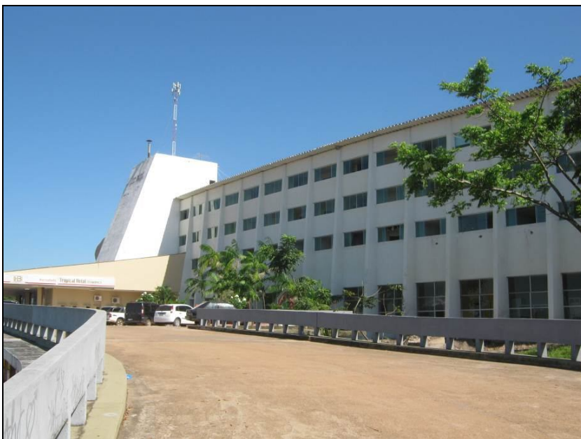
Fotografia 1- Fachada do Hotel Barrudada Tropical (antigo Hotel Tropical) em Santarém.
