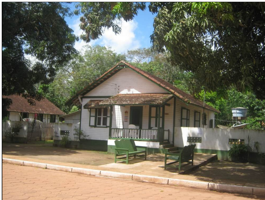
Fotografia 12 - Arquitetura americana do norte no centro histórico de Belterra
