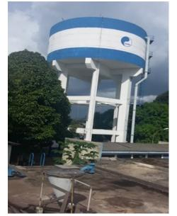
Fotografia 5 - Reservatório elevado 1200 m³ do SAA em Breves
