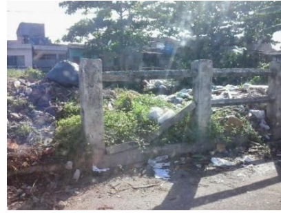
Figura 13 - Despejo irregular de RSU nas margens Canal Água Cristal, no bairro da Marambaia, Belém-PA.
