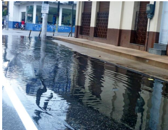
Figura 22: Rua Curuçá com alagamento
