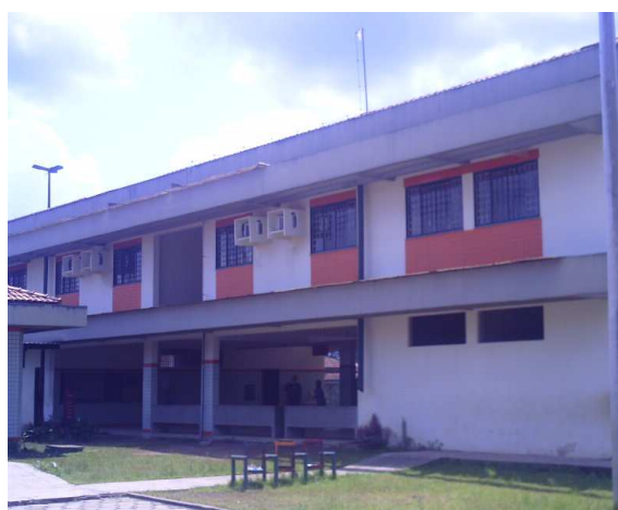
Foto 2: Bloco Pedagógico da Escola
