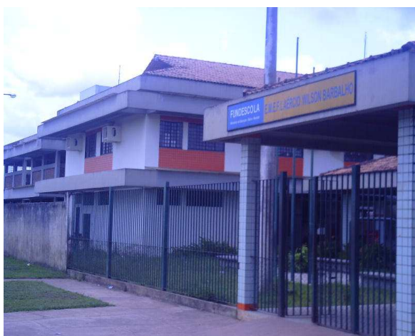
Foto 1: Fachada da Escola pesquisada
