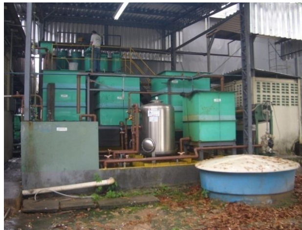
Figura 2.5. Estação de tratamento de efluentes da indústria de injeção plástica. (Cosmosplast Indústria e Comércio de Plástico LTDA, 2009)
