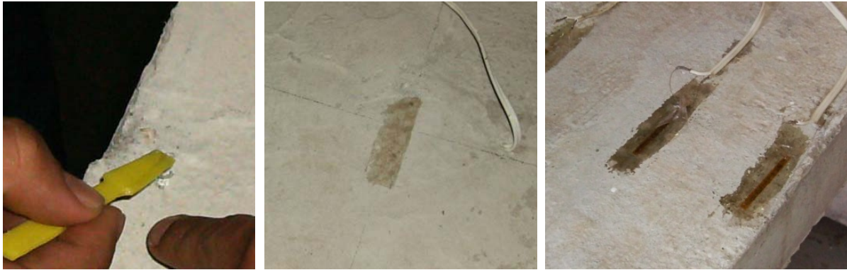
Figura 3.18 – Etapas de instalação dos extensômetros no concreto
