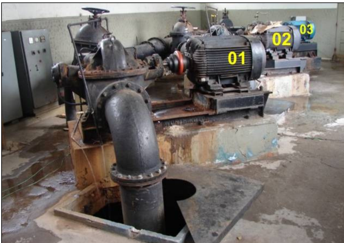
Fotografia 10 - Estação elevatória do 3º setor de abastecimento
