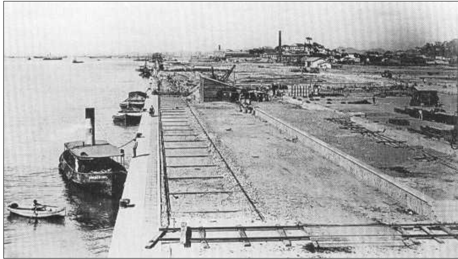
Figura 2: Início das obras do cais da Gamboa. Fonte: Arquivo CDRJ.
