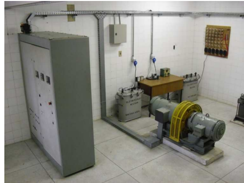
Figura 1: Fotografia do Grupo Gerador e da cadeia de medição e controle.
