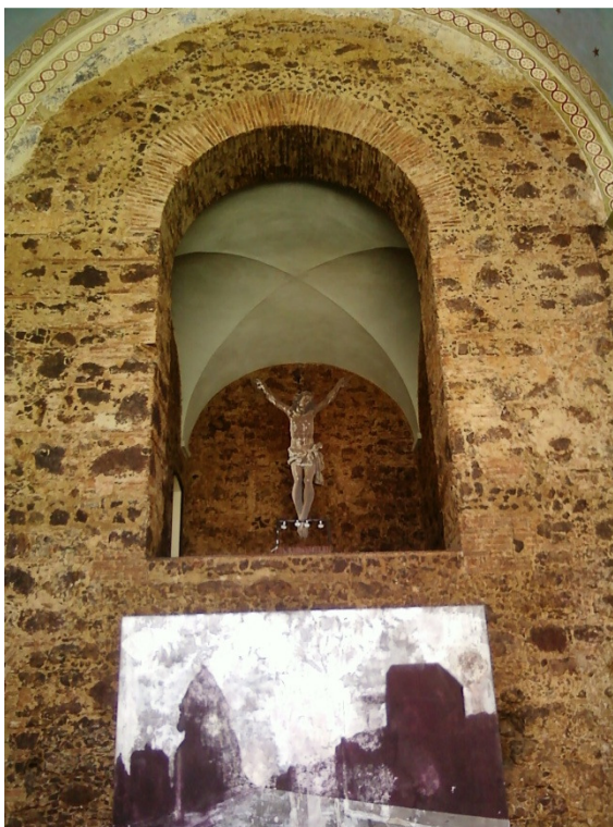
Figura 1: Remoção do reboco de revestimento da Capela do São José Liberto.
