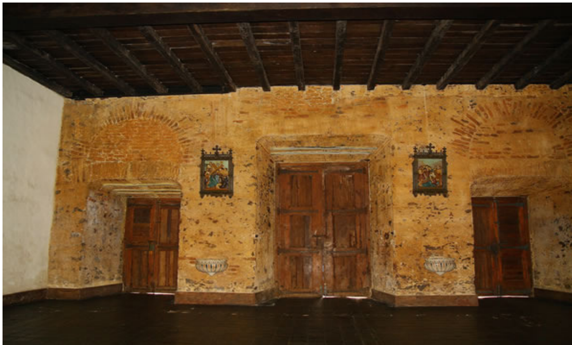
Figura 9: Remoção do reboco da alvenaria frontal da Igreja de Santo Alexandre.
