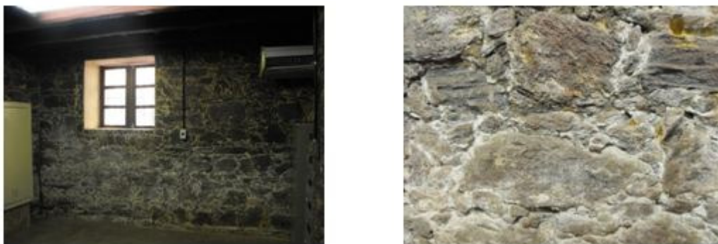
Figura 2: Eflorescências situadas em alvenaria no porão do Arquivo Público do Estado do Pará.
