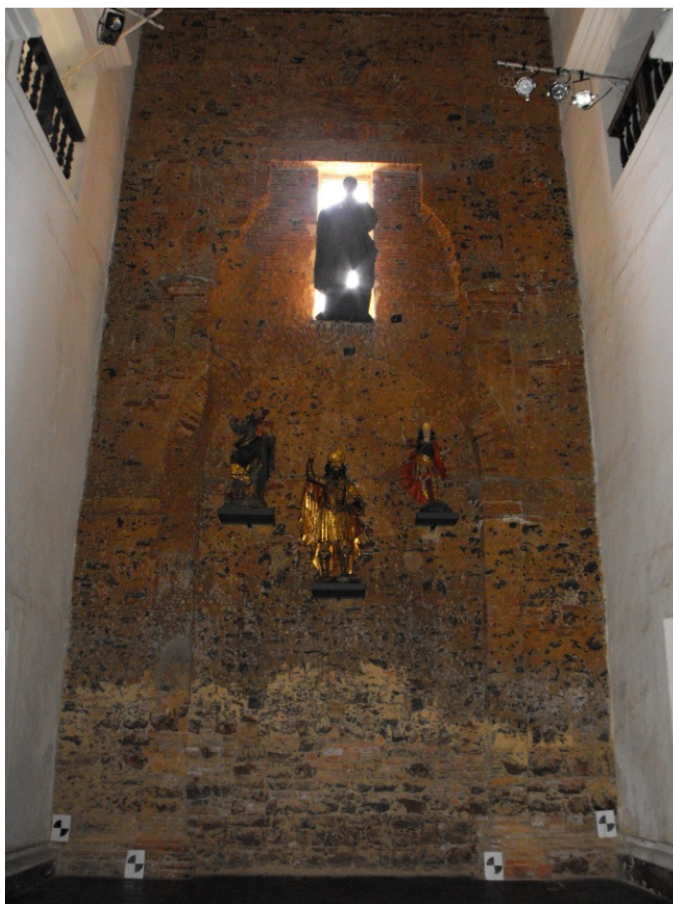
Figura 12: Capela do transepto direito da Igreja de Santo Alexandre.
