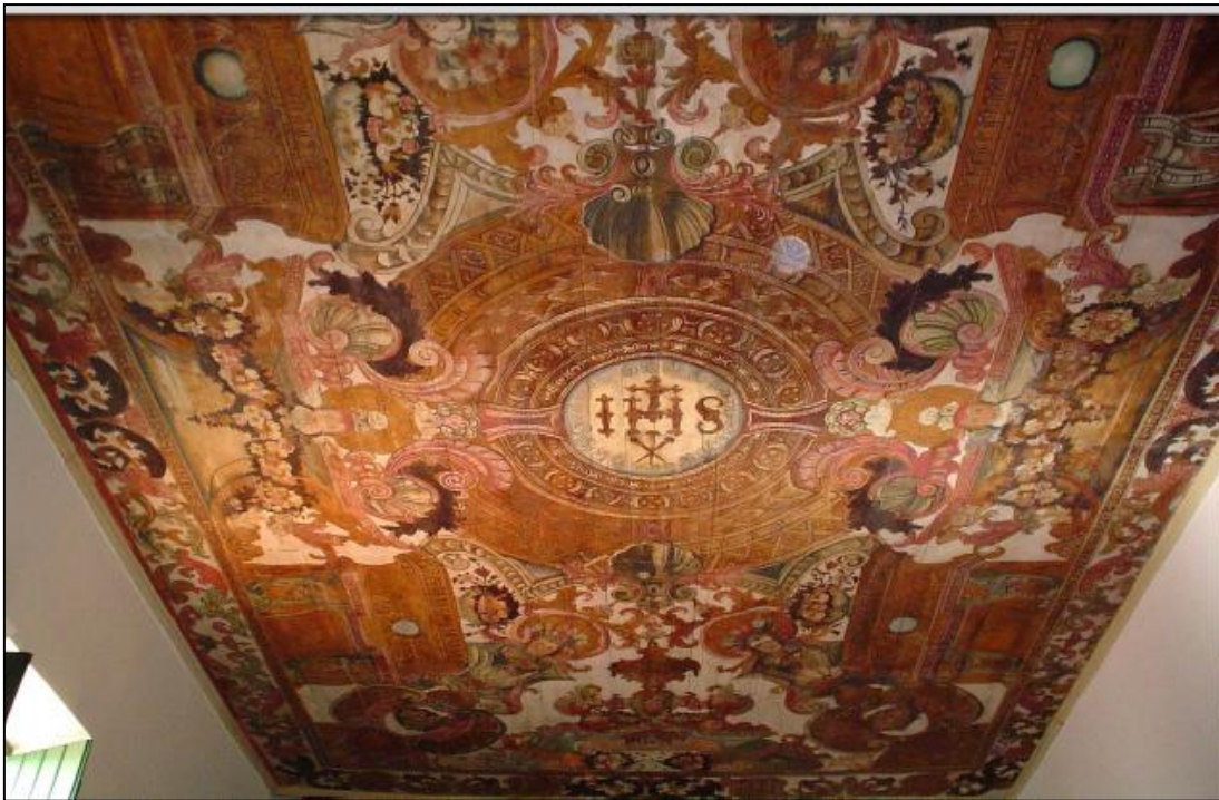
Figura 15: Forro do Consistório da igreja de Santo Alexandre.
