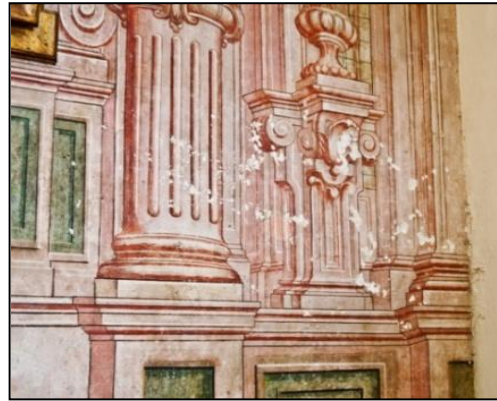
Figura 4: Detalhe do retábulo: danos na pintura.
