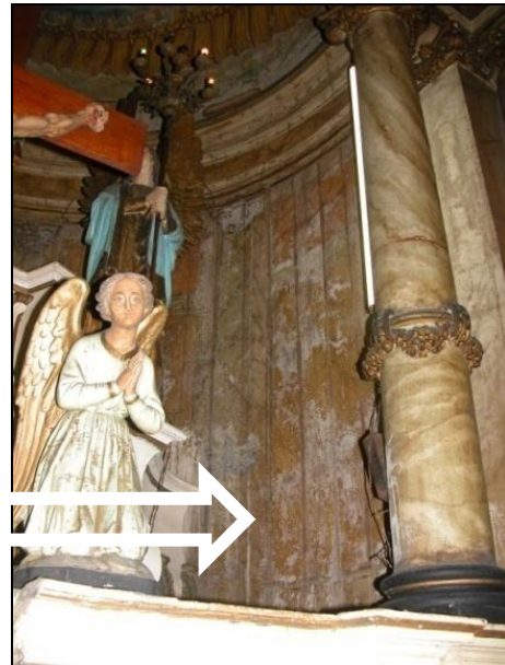
Figura 18: Detalhe da pintura do retábulo.
