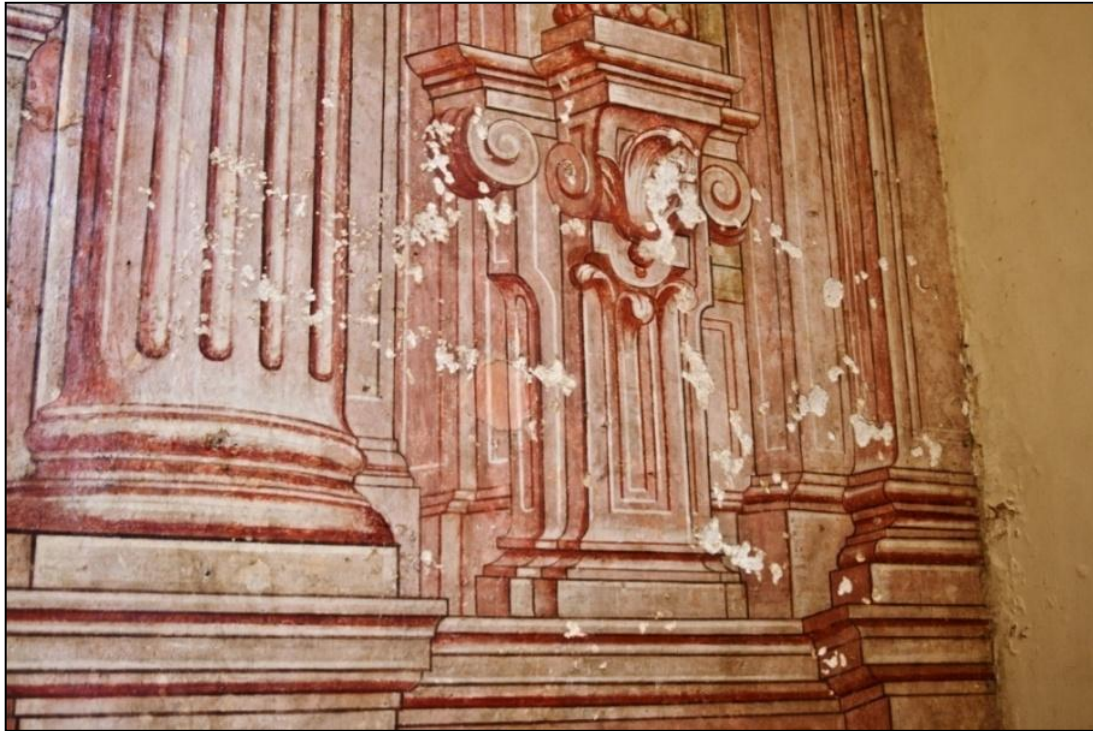
Figura 24: Danos sofridos pela pintura de quadratura no retábulo-mor da igreja de São João.
