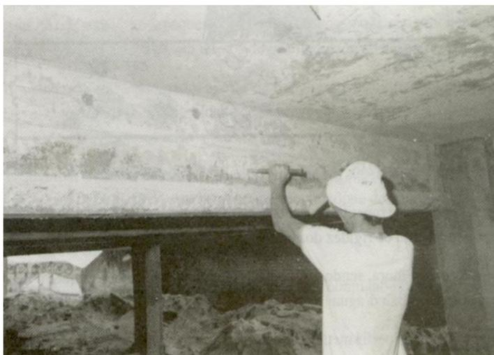
Figura 2.25 – Apicoamento manual da superfície de concreto (Souza e Ripper, 1998)
