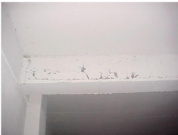
Figura 2.21 - Elementos em concreto armado com segregação.
