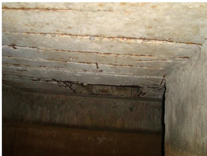
Figura 2.14 – Corrosão da armadura em laje.
