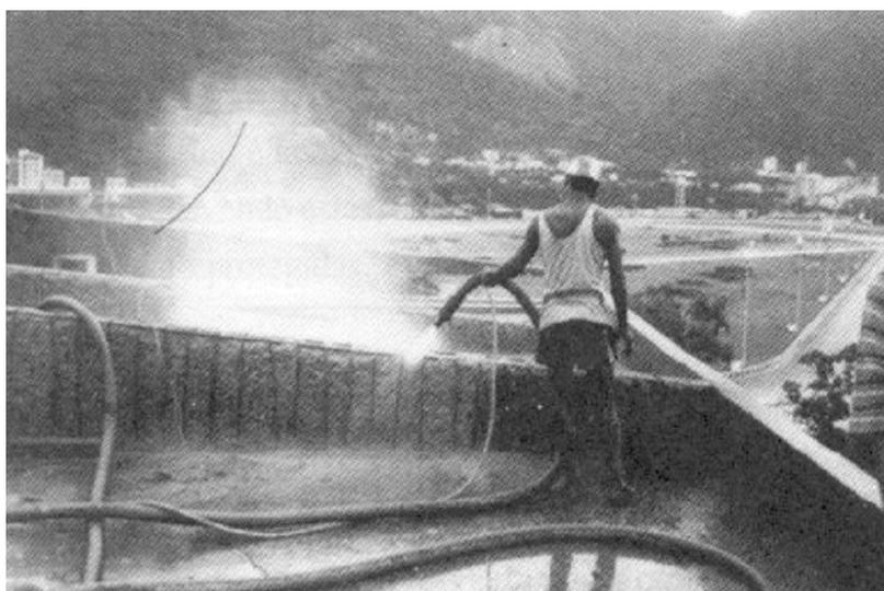
Figura 2.22 – Aplicação de jatos de água para lavagem de superfície de concreto (Souza e Ripper, 1998)
