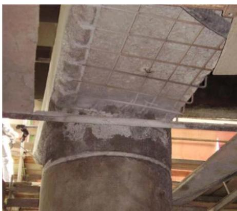
Figura 2.45 - Viga preparada para receber reforço com concreto projetado e pilar já executado o reforço.
