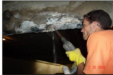
Figura 2.38 – Processo de furação para colocação dos tubos de injeção (Zapla, 2006)
