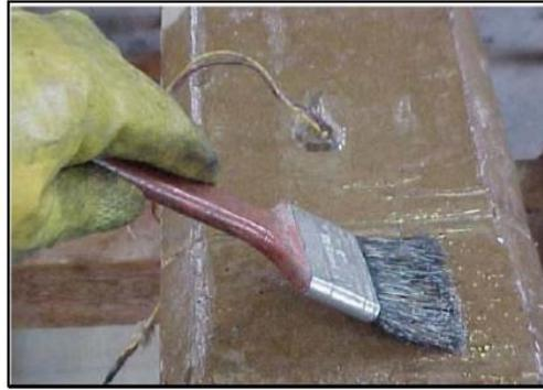
Figura 2.53 – Limpeza com estopa umedecida (esquerda) e aplicação da resina primária (direita) – (Rigazzo, 2003).
