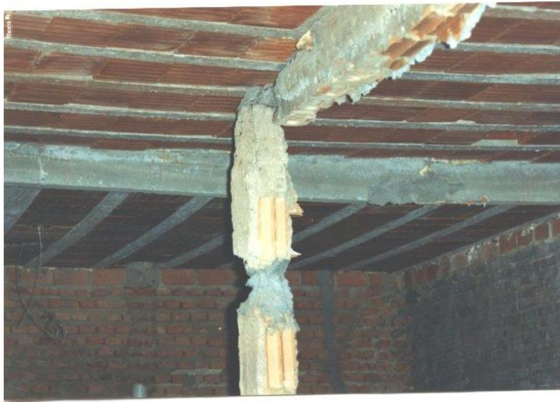
Figura 2.19 – Viga e Pilar em concreto armado com imperfeição geométrica.
