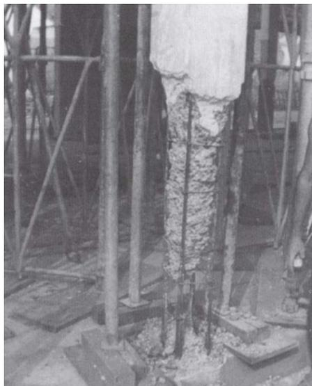
Figura 2.29 – Escoramento de estrutura para suportar a remoção total do concreto do pilar a ser recuperado (Cánovas, 1988)
