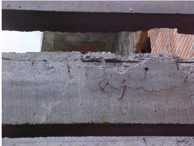
Figura 2.18 - Vigas em concreto armado sem qualidade no concreto de cobrimento.
