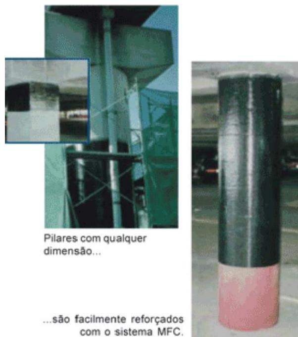
Figura 2.49 – Pilares reforçados com o sistema PCRf. (Rogertec, 2006).
