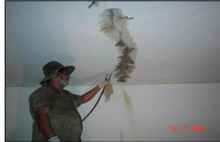
Figura 2.39 – Processo de injeção em fissuras (Zapla, 2006)
