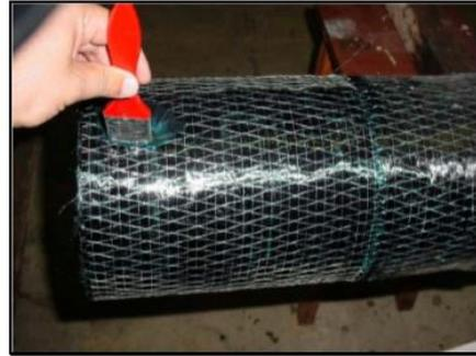
Figura 2.54 – Aplicação da manta e da resina de colagem (esquerda) e por final aplicação de resina saturante (direita) – (Rigazzo, 2003).
