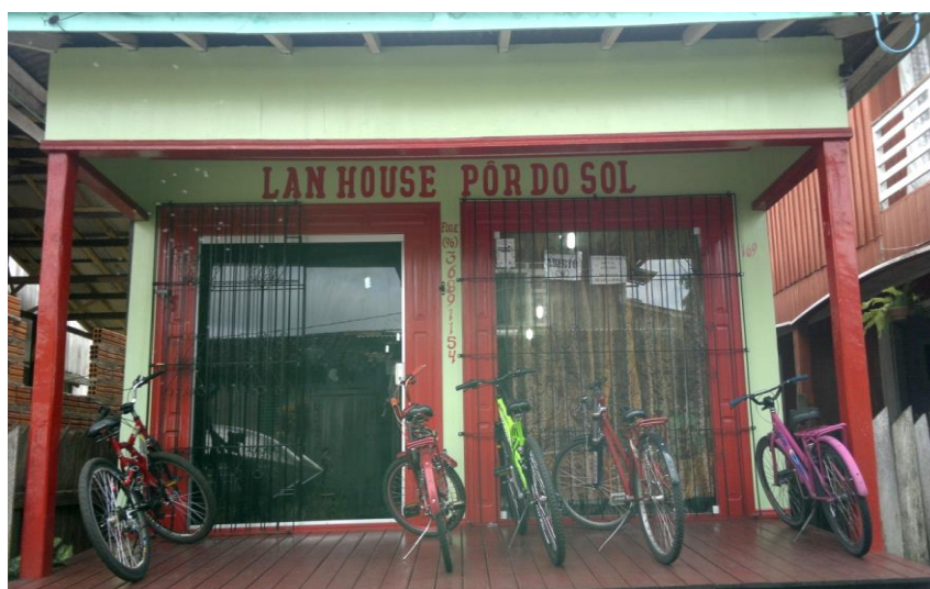
Figura 44: Fachada da Por do Sol (Foto: Diogo Miranda).
