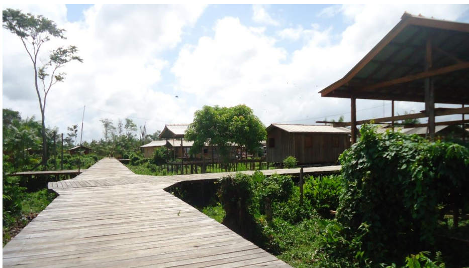
Figura 61: Ruas-palafitas sem poste (Foto: Diogo Miranda).
