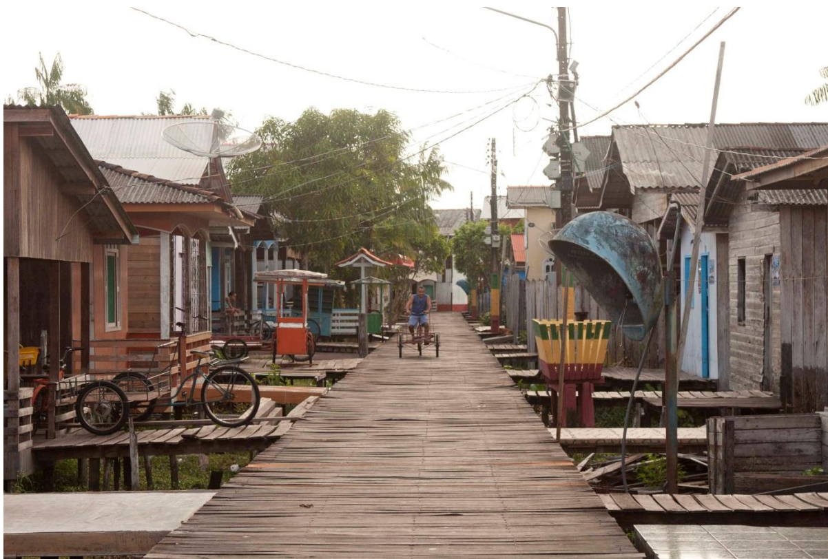
Figura 36: Ruas conectadas do Centro de Afuá (Foto: Shilery Penaforte).
