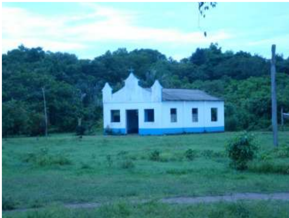
Figura 22: Igreja Católica em Aracy Fonte: Autor (24/01/2008)
