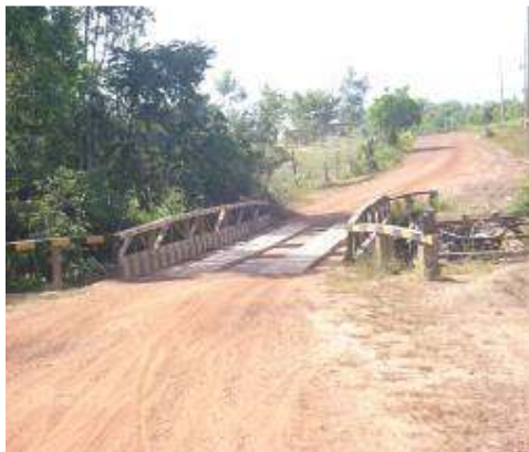
Figura 10 - Ponte na Translagos - PA 257 Fonte: Autor /Agosto de 2008.
