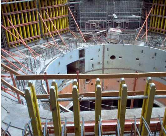
**Figura 3.10a – Poço do estator do gerador**
