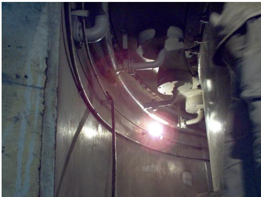
**Figura 3.10c – Detalhe do tranqüilizador de óleo**
