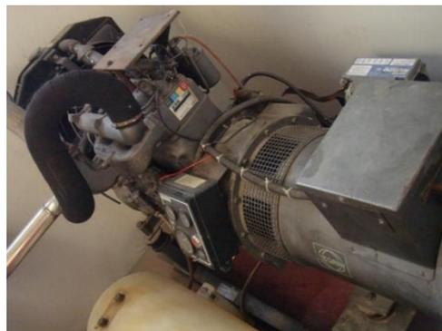
Figura 37 - Detalhe do sistema de resfriamento.
