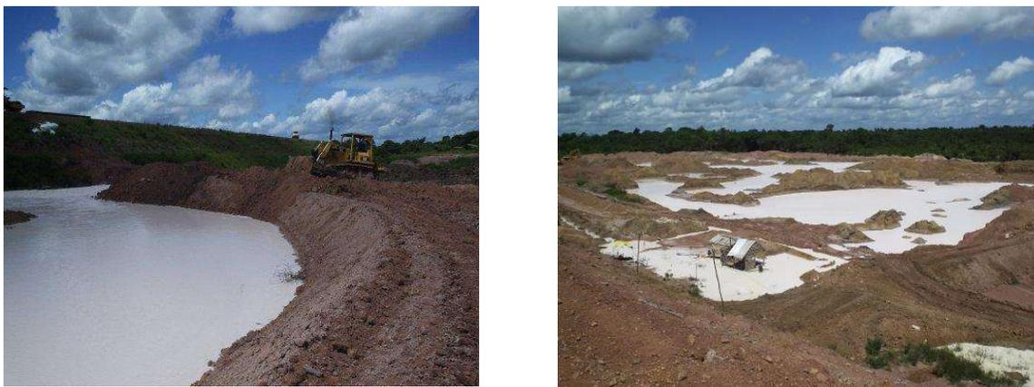
**Figura 3:** (a) e (b) Formação dos taludes de uma lagoa de caulim.
