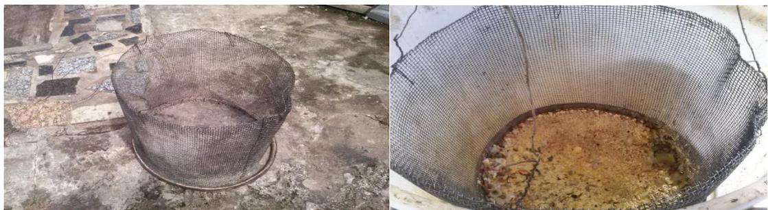
**Figura 4.4-** Peneiramento e retenção de resíduos dentro do tanque de PEAD.
