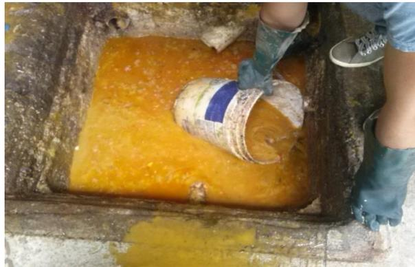
**Figura 4.1** - Coleta do Material Residual Gorduroso das Caixas de Gordura do RU-UFPA.
