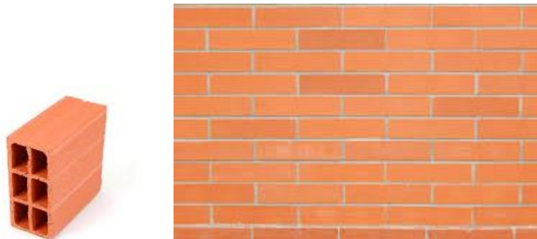
Figura 2.4 - Bloco e alvenaria de tijolos cerâmicos
