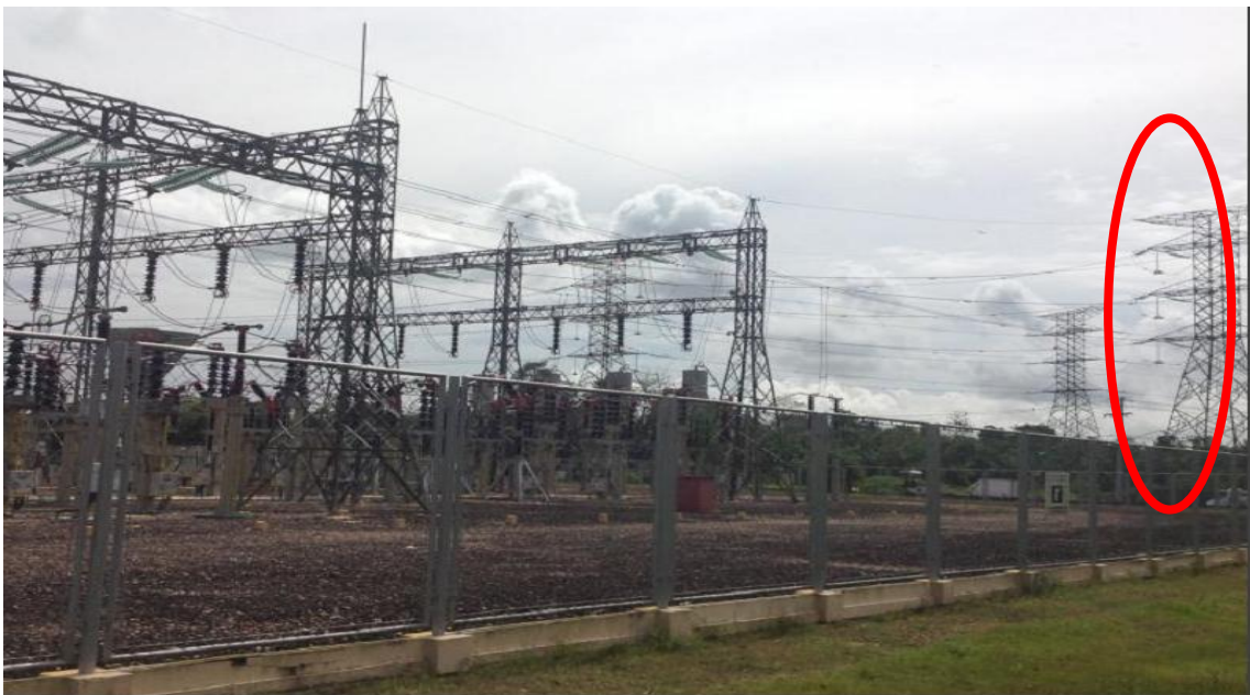
Figura 3.4 - Detalhe das linhas de transmissão Vila do Conde-Guamá 1 e 2
