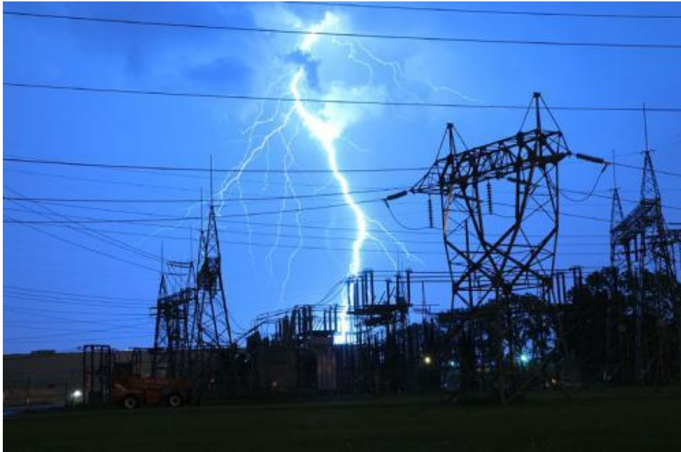
Figura 1.2 – Falha em Subestação
