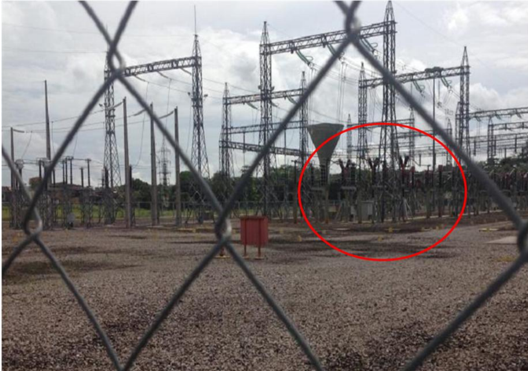
Figura 3.8 - Detalhe do bay de interligação ao fundo
