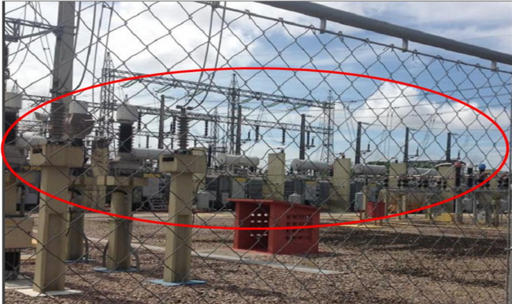
Figura 3.6 - Detalhe dos bancos de transformadores e linhas de interligação
