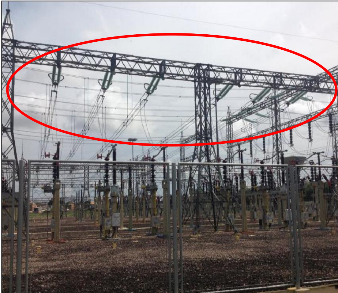
Figura 3.9 - Detalhe das barras
