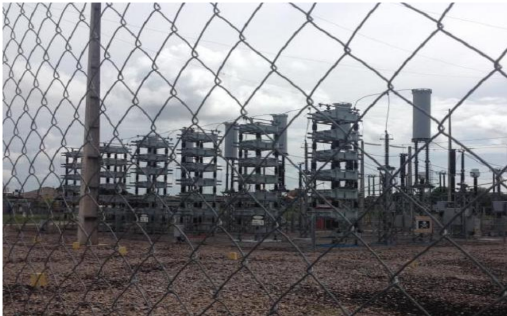
Figura 3.7 - Detalhe dos bancos de capacitores
