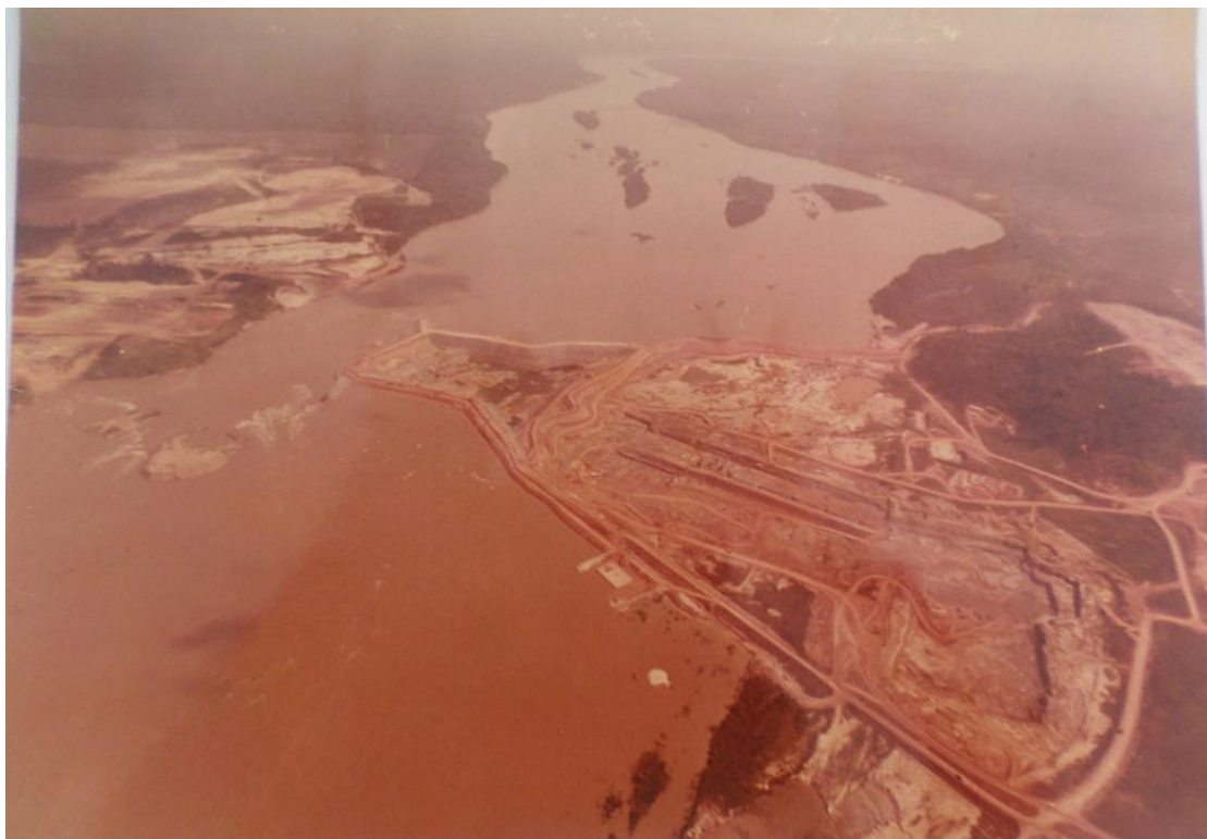
Imagem 4: Vista área da barragem em construção, bloqueando o Rio Tocantins parcialmente. Álbum da hidrelétrica de Tucuruí, Eletronorte centrais elétricas do norte do Brasil do Brasil S. A (Usina Hidrelétrica do Pará) de 1980. Acervo diocese de Cametá.
