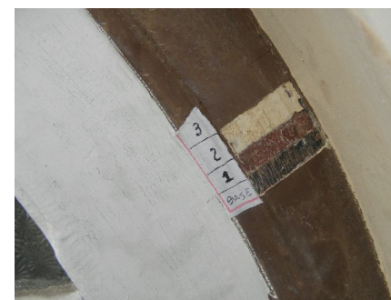
Fig.D3.4 Prospecção no alisar Foto - Antôno Fábio de Oliveira
