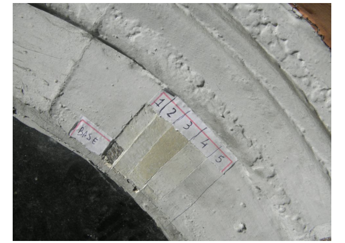
Fig. D.4.5 Prospecção na esquadria da porta-janela Foto - Antônio Fábio de Oliveira
