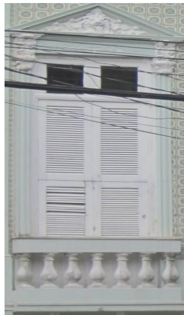
Fig. 34 - Janela com verga reta com frontão triangular e ombreiras ornamentadas Fonte: Maria Beatriz Faria
