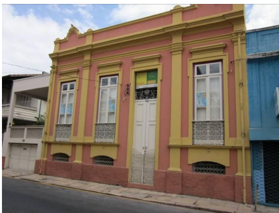
Fig. 31 - Fachada com modenatura dividida por pilastras Fonte: Maria Beatriz Faria (2013)
