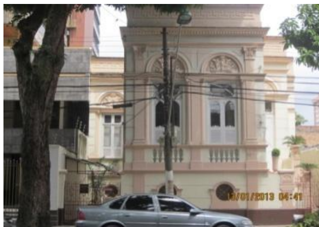
Fig. 64 - Residência com afastamento lateral e frontal. Entrada feita através de escadaria descoberta Fonte: Maria Beatriz Faria (2013)
