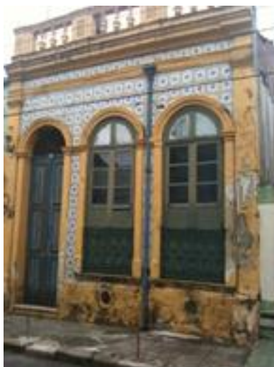
Fig. 59 - Casa com Porta de entrada no alinhamento da via pública Foto: Maria Beatriz Faria
