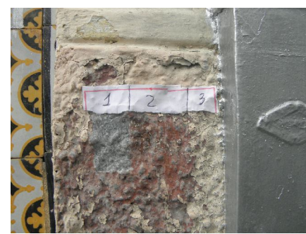
Fig.D3.6 Prospecção no embasamento Foto - Antônio Fábio de Oliveira
