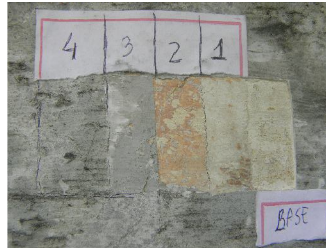
Fig. D.4.2 Prospecção no friso do entablamento Foto - Antônio Fábio de Oliveira
