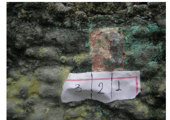
Fig. D2.7 Prospecção no embasamento Foto - Antônio Fábio de Oliveira
