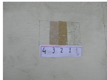
Fig.D3.2 Prospecção no friso do entablamento Foto -Antônio Fabio de Oliveira
