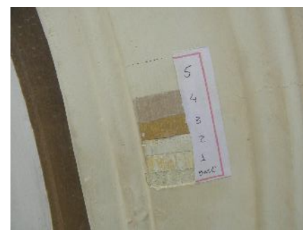
Fig.D3.3 Prospecção na moldura do vão e cimalhas Foto - Antônio Fábio de Oliveira
