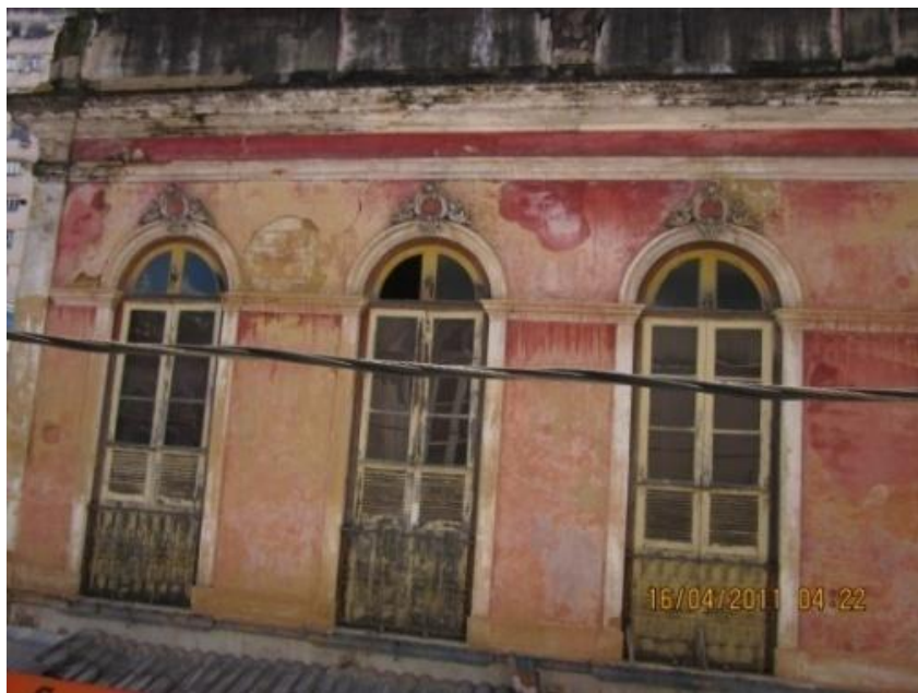
Fig.49 - Portas-janelas com esquadrias de madeira com as folhas das portas pintadas num tom de bege, e as bandeiras das portas em tom de ocre. E alizar marcado com pintura na cor marrom.
