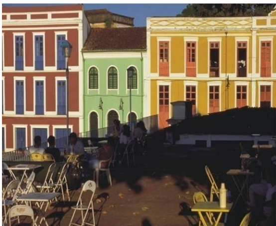
Fig. 4 - Sobrados da ladeira do Castelo após a pintura realizada pela FUNBEL na década de 1990. Fonte: Não identificada [s.d.]
