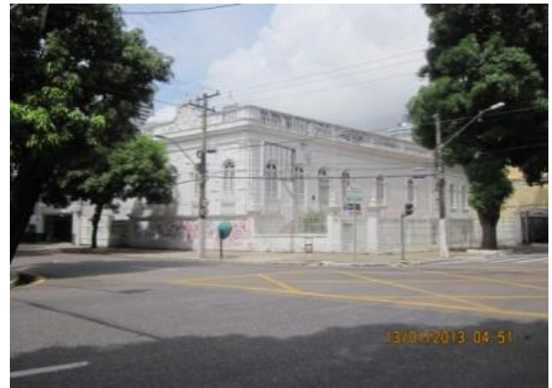
Fig. 63 - Residência com afastamento lateral onde estão situados o alpendre e entrada lateral Fonte Maria Beatriz Faria (2013)
