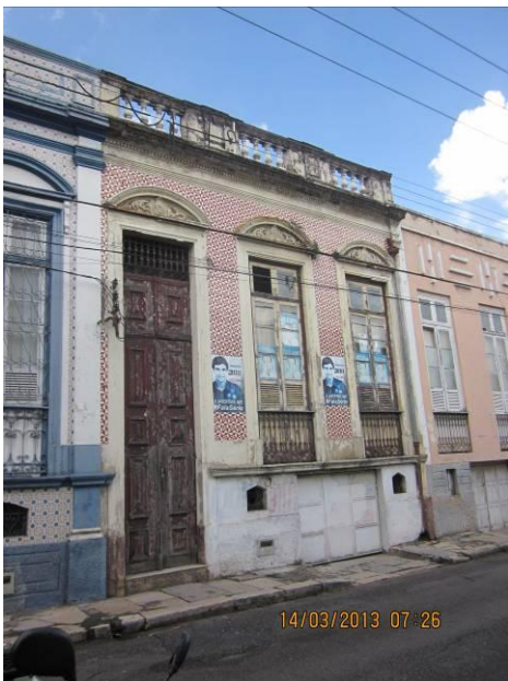
Fig. 33 - Fachada com verga reta com frontão cimbrado Fonte: Maria Beatriz Faria
