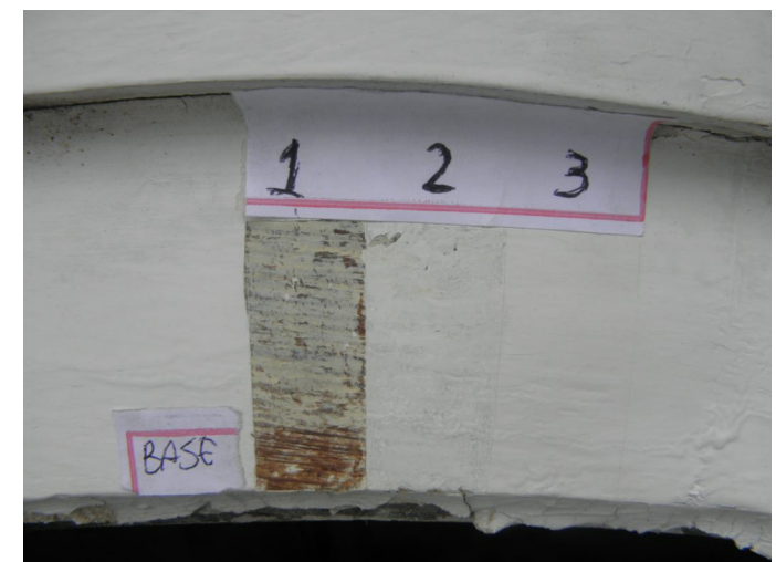
Fig. D1.4 Prospecção na esquadria da porta-janela Foto - Antônio Fábio de Oliveira
