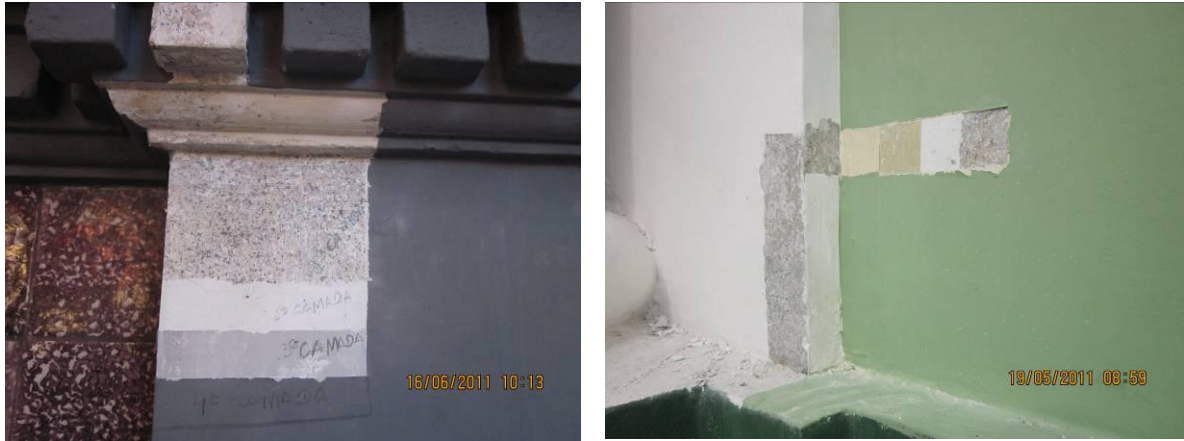
Fig. 45 e Fig. 46 - Prospecção do Sobrado na Benjamin Constant, e do Quartel General onde foram encontrados fingidos pontilíneos Fonte: Maria Beatriz Faria (2013)
