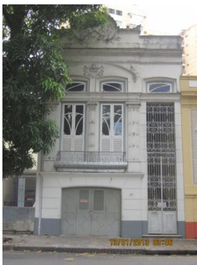
Fig. 61 - Fachada com portão de ferro Foto: Maria Beatriz Faria (2013)
