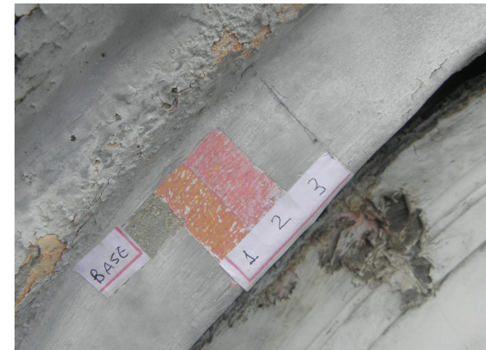
Fig. D1.2 Prospecção na moldura dos vãos e cimalhas Foto - Antônio Fábio de Oliveira
