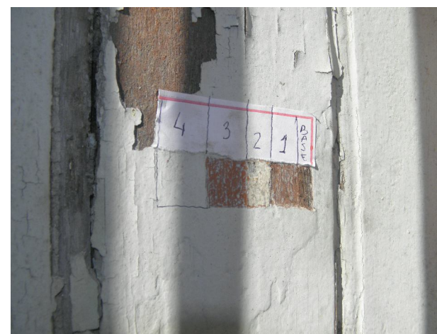
Fig. D.4.6 Prospecção na porta Foto - Antônio Fábio de Oliveira
