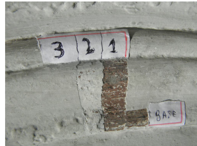
Fig.D.4.4 Prospecção no alisar Foto - Antônio Fábio de Oliveira
