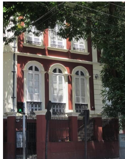
Fig. 56 - Casa situada à Av. Gov. José Malcher- bairro de Nazaré, com pintura recente Fonte: Maria Beatriz Faria (2012)
