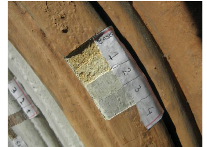
Fig. D.4.3 Prospecção na moldura do vão e cimalhas Foto - Antônio Fábio de Oliveira
