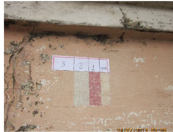
Fig.D2.2 Prospecção no friso do entablamento Foto - Antônio Fabio de Oliveira
