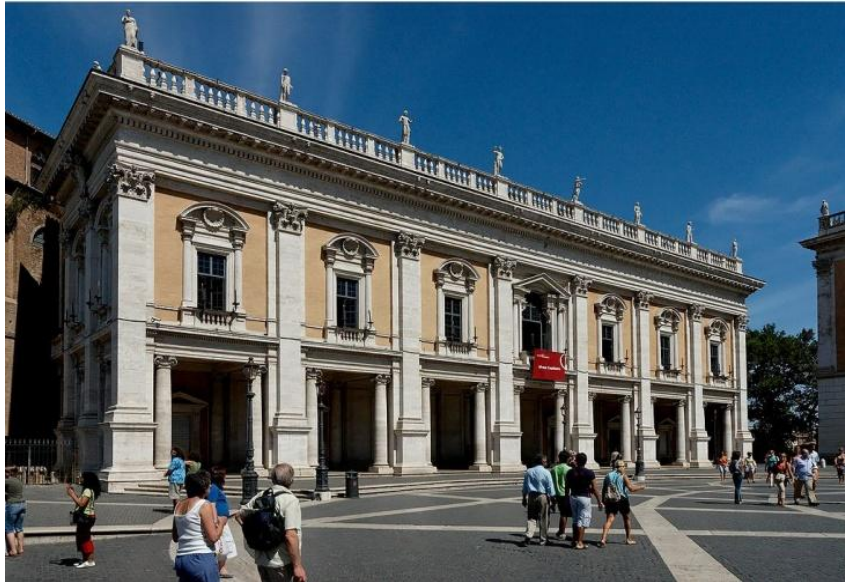
Fig. 17 - Fachada dos Palácios Gêmeos Fonte: http://commons.wikimedia.org/wiki/File:Facade_Palazzo_Nuovo_Roma.jpg
