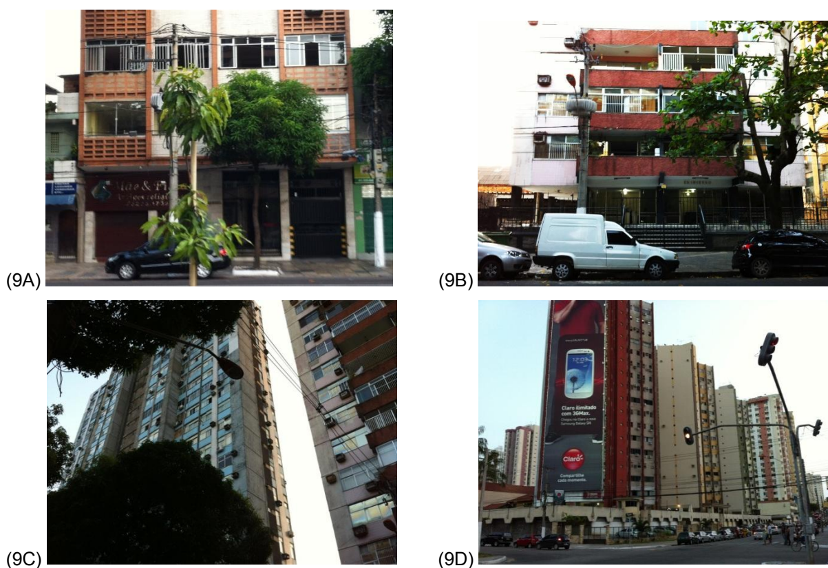
Figura 9 – Verticalização em Belém durante as décadas de 1970 e 1980. 9A: Edifício construído antes de 1979 e ocupando a totalidade do lote; 9b e 9C: Edifícios construídos durante os anos 1980 obedecendo às primeiras diretrizes para afastamentos vigentes na época; 9D: Uns dos primeiros edifícios construídos nos bairros do Reduto e em áreas urbanizadas pela macrodrenagem da bacia das Almas. Destaque para o pavimento de garagem implantada no nível da rua em decorrência da impossibilidade técnica de realizar escavações na área. Fotos: Ventura Neto (2012).
