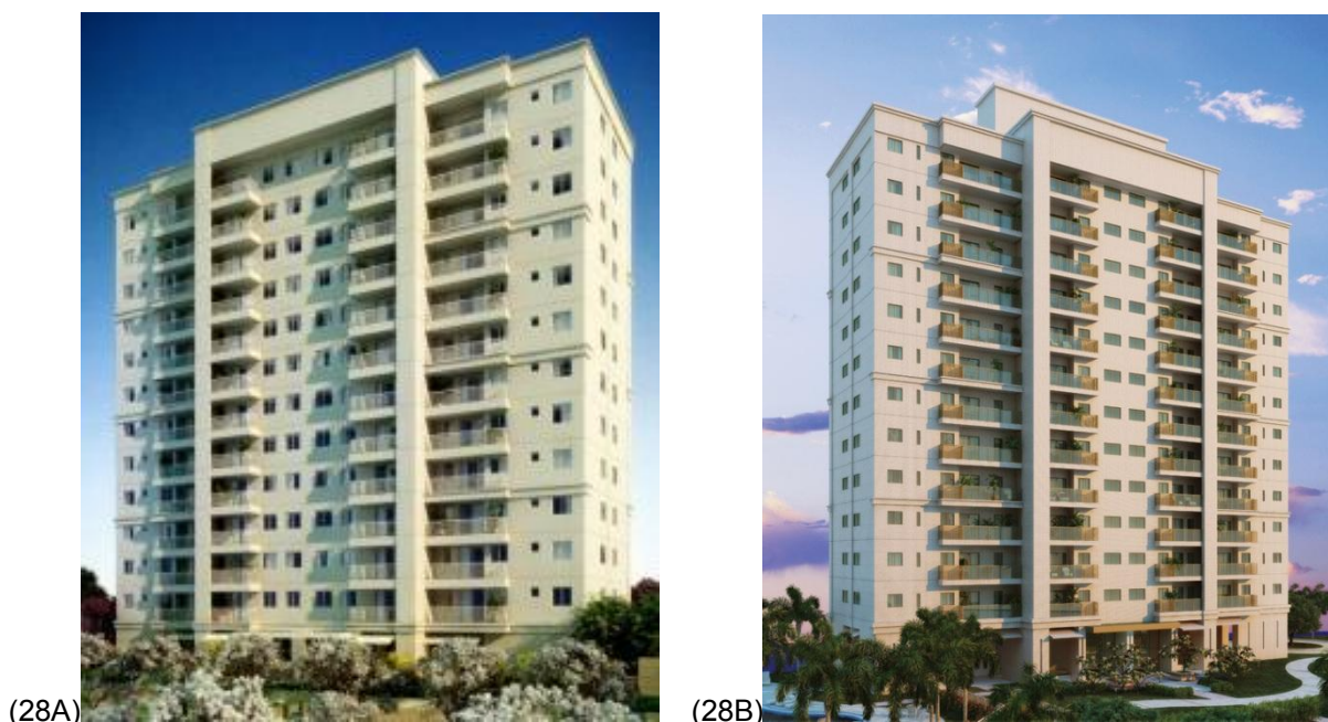
Figura 28 – 28A e 28B Empreendimento da Cyrela (Jardim de Provence) em execução na região da Augusto Montenegro e o mesmo projeto em execução na cidade de São Luís (Jardim de Toscana). Fonte: CYRELA (2012).
