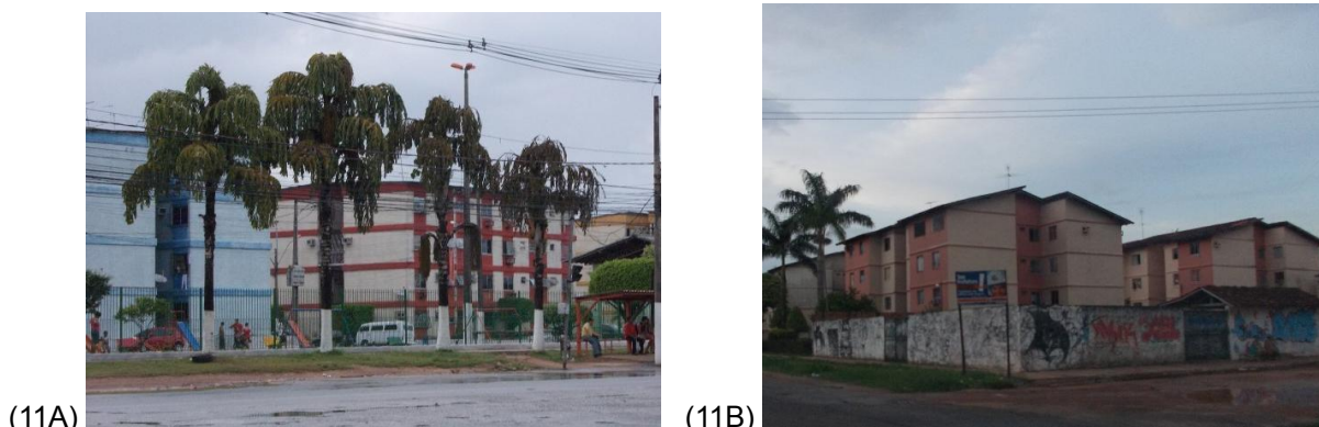
Figura 11 – Empreendimentos imobiliários realizados através do programa de Cooperativas Habitacionais ao longo da rodovia Augusto Montenegro. Fotos: Ventura Neto (2012).
