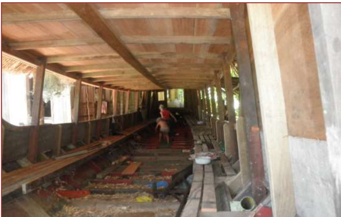
FOTO 16: Crianças brincando no interior de uma embarcação em construção Fonte: Waldiléia Amaral, registro de campo 2014
