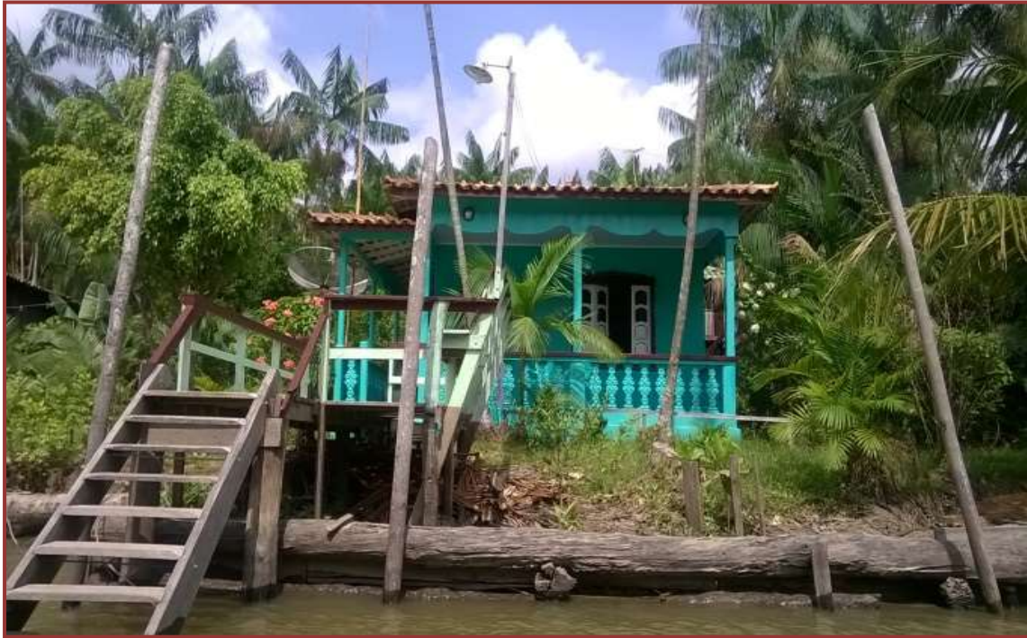
FOTO 4: Casa pintada e avarandanda com escada para embarque e desembarque de pessoas. Fonte: Waldiléia Amaral, registro de campo 2014
