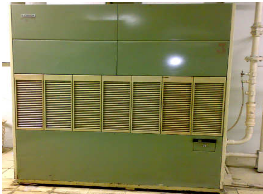
Figura 4.6: Torre de resfriamento à água – Condicionador de Ar Hitachi Modelo RP 2014 Fonte: IBT (2010).
