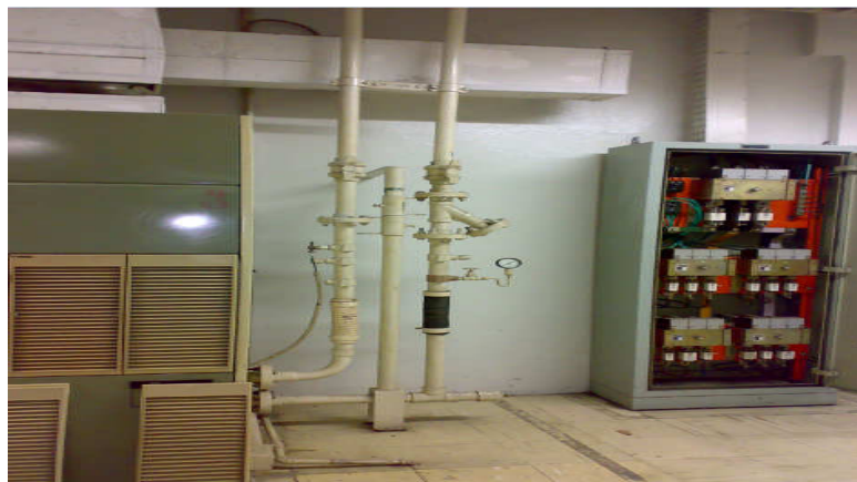
Figura 4.9: tubulação de Controle dos Flúídos de Pressão da Torre de Resfriamento Fonte: Indústria Brasileira de Televisores – IBT ( 2010 ).
