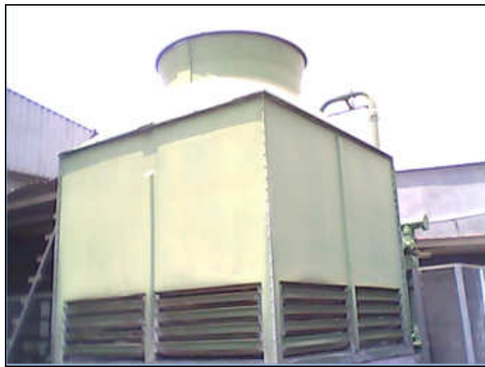
Figura 5.4: Ventilador que resfria a água para a Torre de Resfriamento Fonte: IBT (2010).
