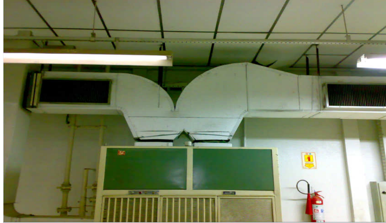
Figura 4.8: Condutores de ventilação da Torre de resfriamento Fonte: IBT (2010).
