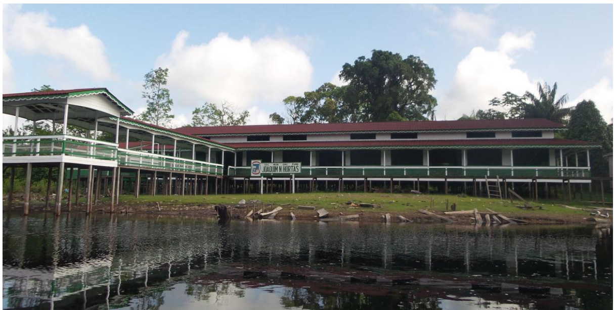
FIGURA 8. Escola Municipal de Ensino Fundamental Joaquim Hortas, em Nossa Senhora de Nazaré do Lago do Jacaré, vilarejo-sede comunitária da RESEX Mapuá, Breves, PA, 2015. Estrutura possui seis salas de aula e dependências administrativa e pedagógica.
