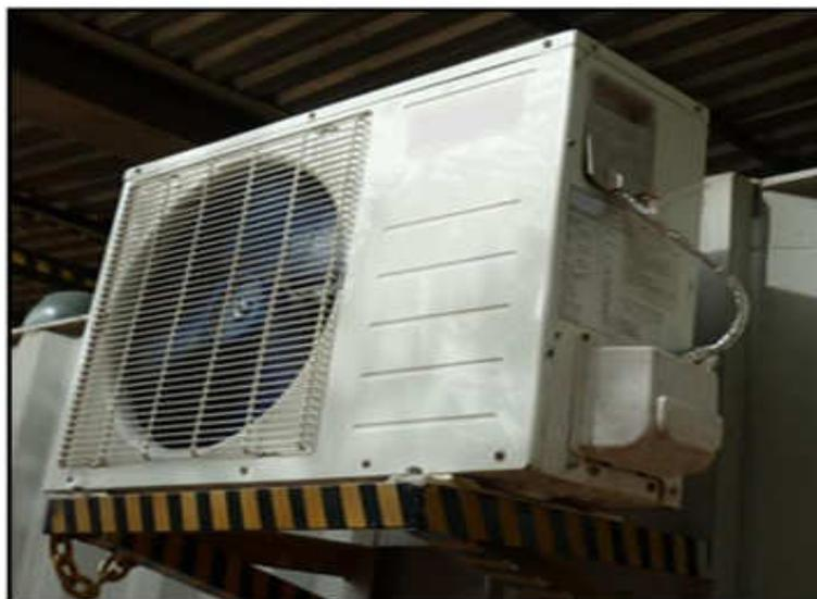
**Figura 2.14:** Unidade Condensadora de Condicionador de Ar Residencial
