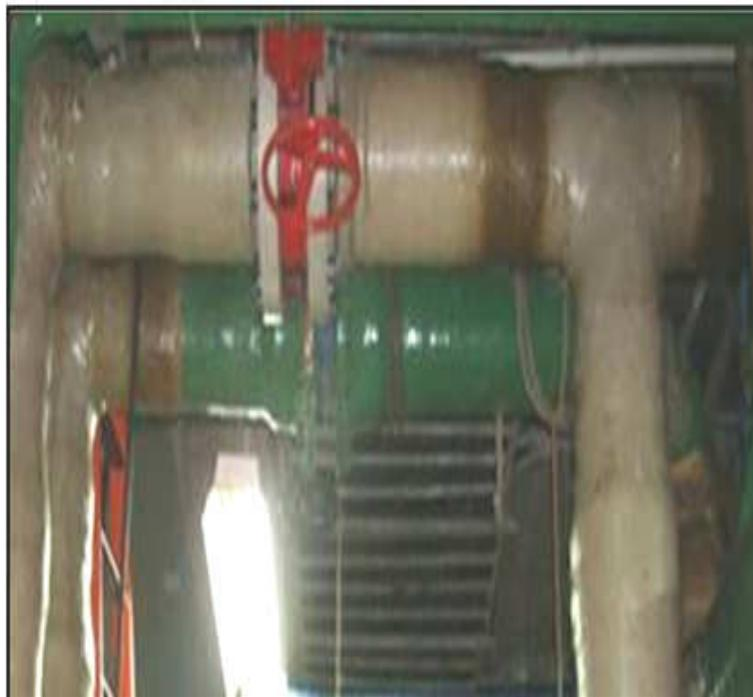
**Figura 4.12:** Detalhe do Corte e Solda na Tubulação
