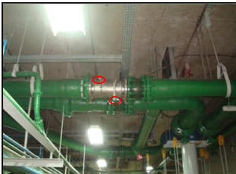
**Figura 5.2:** Sensores do Medidor Ultra Sônico
