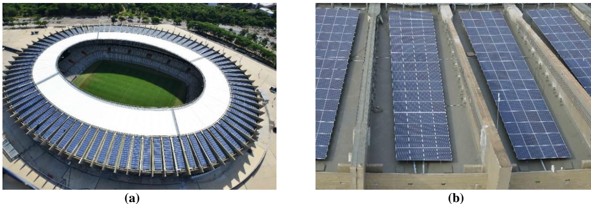
Figura 8 - Usina solar fotovoltaica Mineirão. (a) Instalação dos módulos na cobertura do estádio. (b) Detalhe da instalação.
