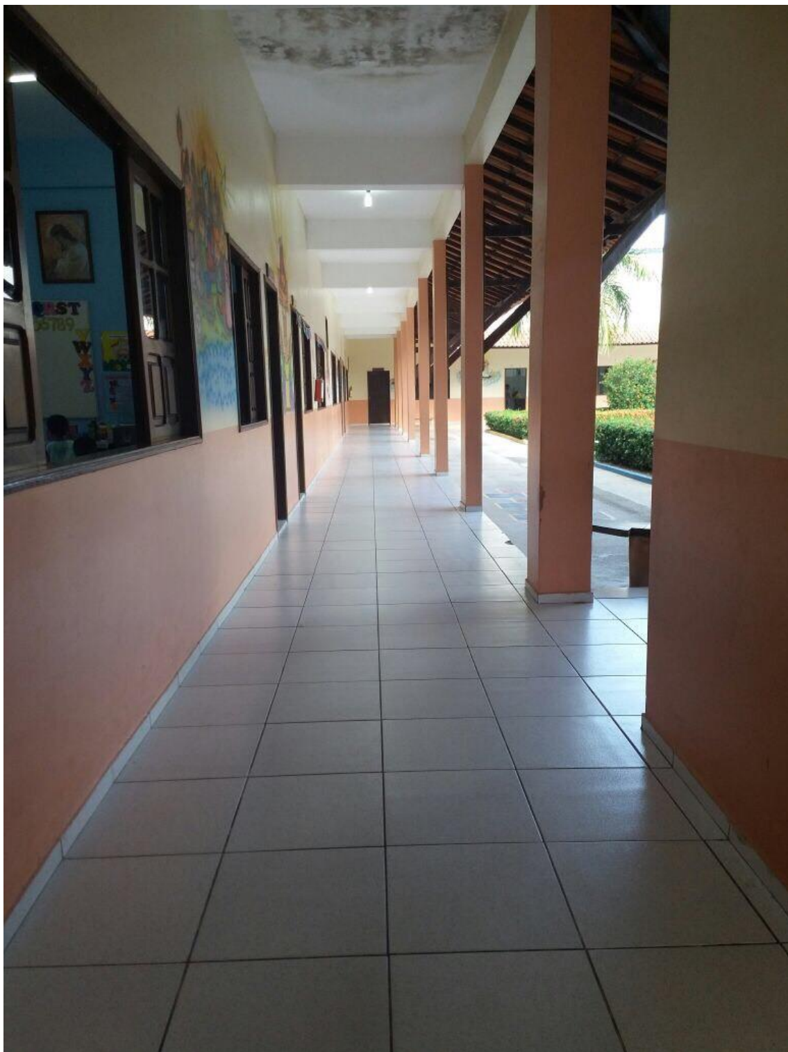
Corredor da escola.
