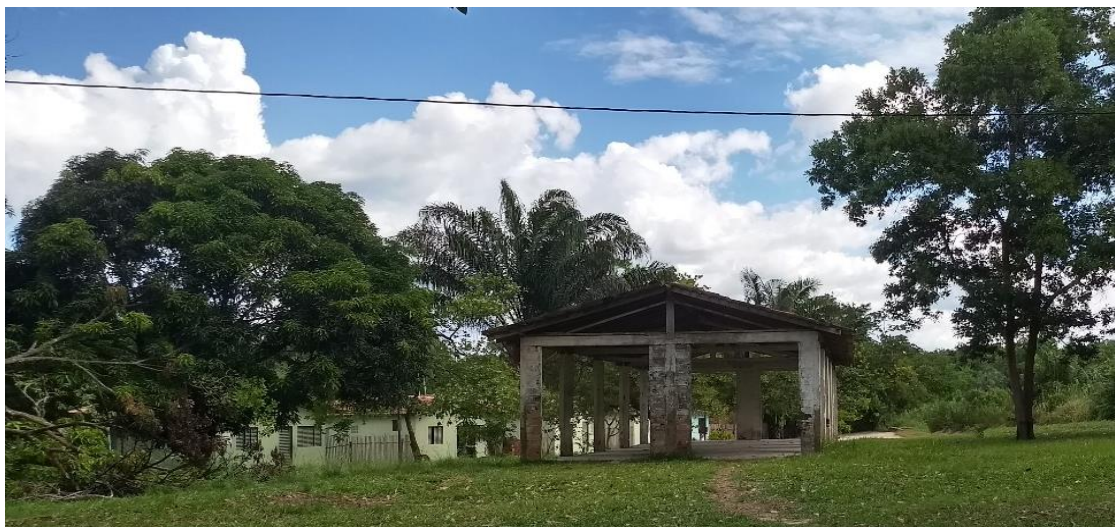
Fotografia 5 – Barracão da comunidade Santa Rita de Barreira
