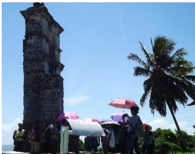
Fotografia 2- Ruína da igreja de Nossa Senhora do Rosário de Joanes, Salvaterra-PA
