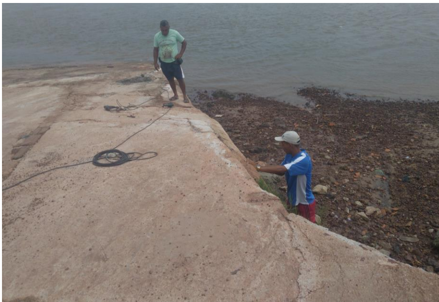
Figura 15 - Manutenção do trapiche de acesso a balsa ou barcos de pequeno porte- trapiche Salvaterra
