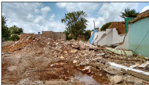
Fotografia 25 - Demolições em Altamira 2
