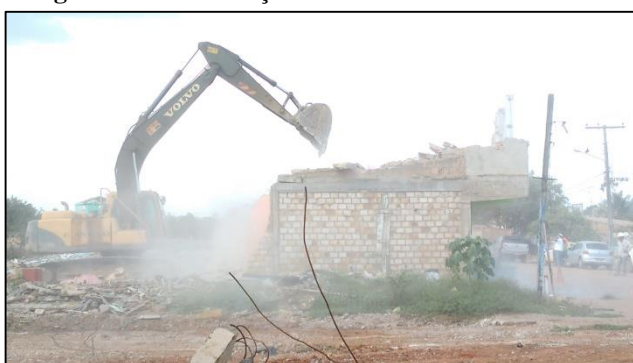
Fotografia 26 - Demolições em Altamira 3
