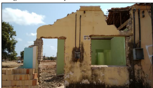
Fotografia 27 - Demolições em Altamira 4
