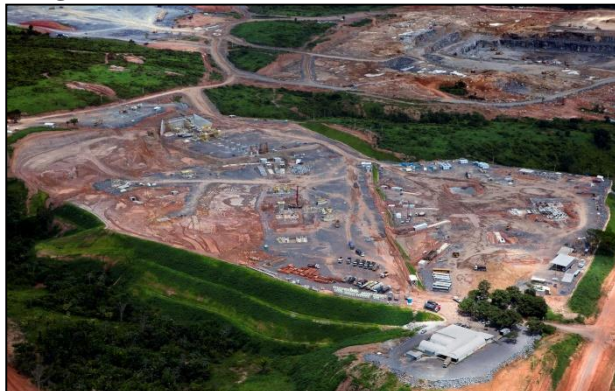
Fotografia 15 - Abertura de canteiros 1.
