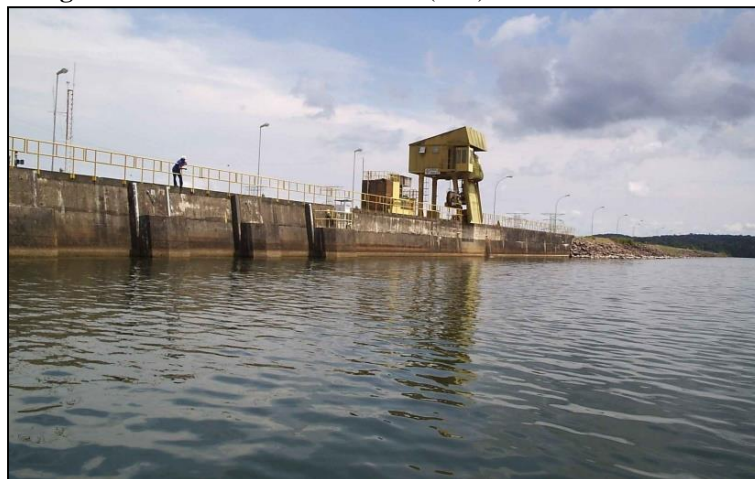
Fotografia 5 - Hidrelétrica de Balbina (AM).
