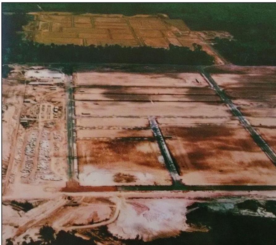
Fotografia 4 - Obras do complexo ALBRÁS/ALUNORTE em Barcarena, anos 80.
