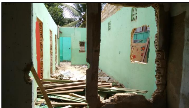
Fotografia 24 - Demolições em Altamira 1
