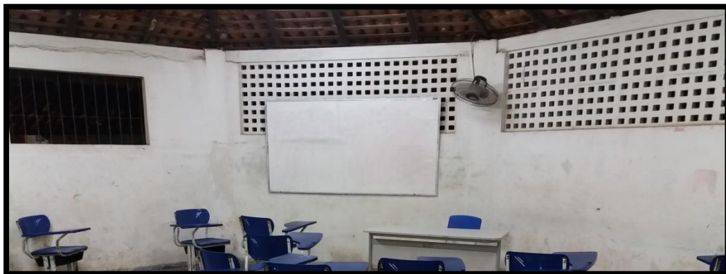
FIGURA 24 - Furos de Ventilação na Sala de Aula FONTE: Próprio autor
