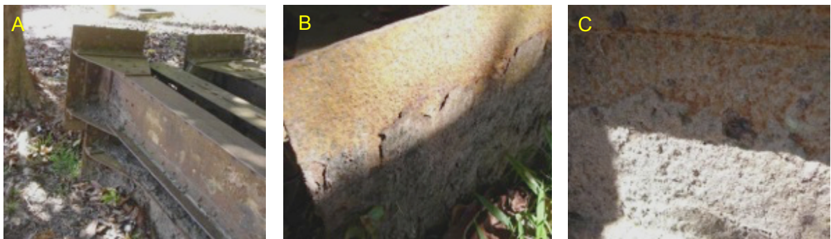
Figura 17 - Peças do antigo chalé de ferro da IOEPA em contato direto com o solo (A, B e C).
